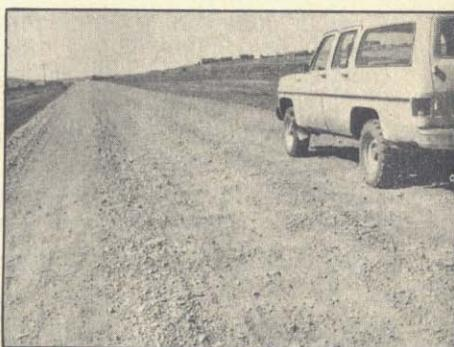
Fotografía 3. Tramo contiguo donde el mismo ripio se niveló simplemente y a los 10 días muestra un acentuado deterioro por el tráfico: ahuellamiento, rugosidad alta, desprendimientos y pozos .  $QI = 90$  cant./Km (Tarea 1). El vehículo de la derecha lleva incorporado el rugosímetro Mays.
