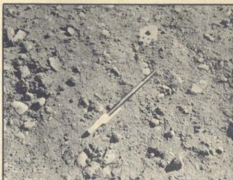
Fotografía 1. Vista de cerca de la capa de ripio antes de compactar con rodillo vibratorio: agregados sueltos o parcialmente aflojados .  $QI = 38$  cant./Km.
