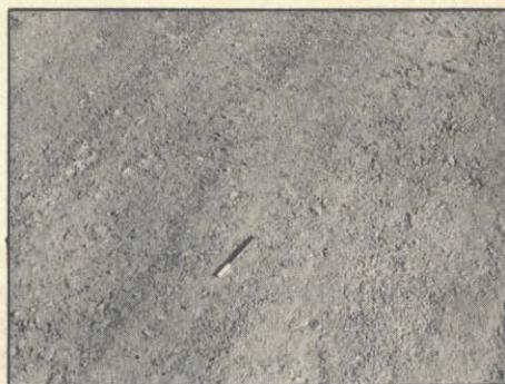
Fotografía 2. Completada la compactación de la superficie enripiada se observa la textura cerrada .  $QI = 34$ .
