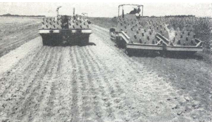
B - 9 Compactación de calzada y banquina.
