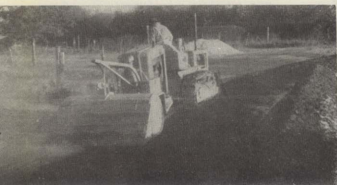
A - 6 Pulverizadora-mezcladora trabajando el primer caballete.
