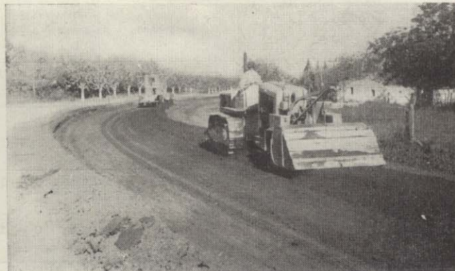
A - 8 Completando el mezclado y traslado del caballete al lado opuesto.
