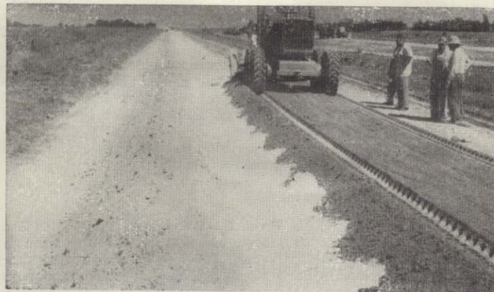
B - 7 Volcando el primer cordón sobre la cal distribuida.
