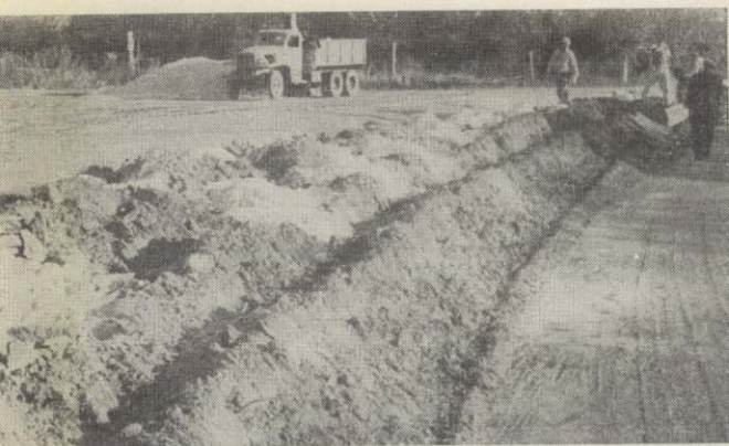
A - 3 Apertura de las bolsas de cal hidráulica.
