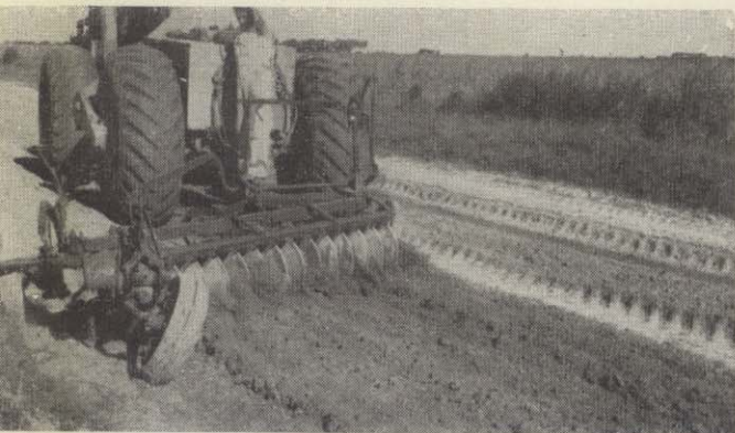
B - 1 Roturación del suelo calcáreo.
