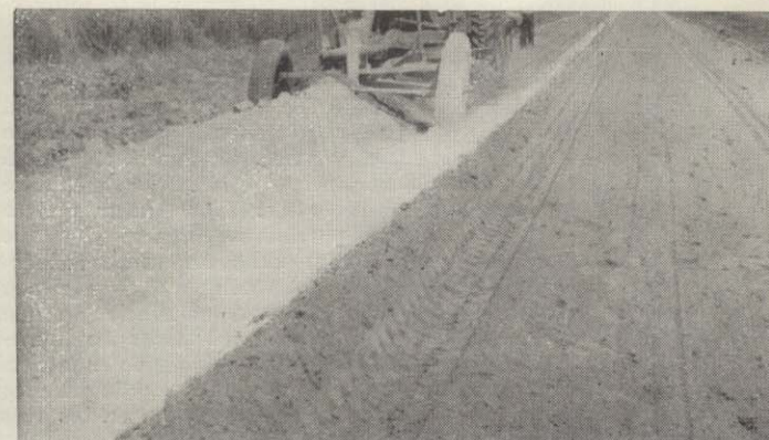
B - 8 Volcando el segundo cordón sobre la cal distribuida.
