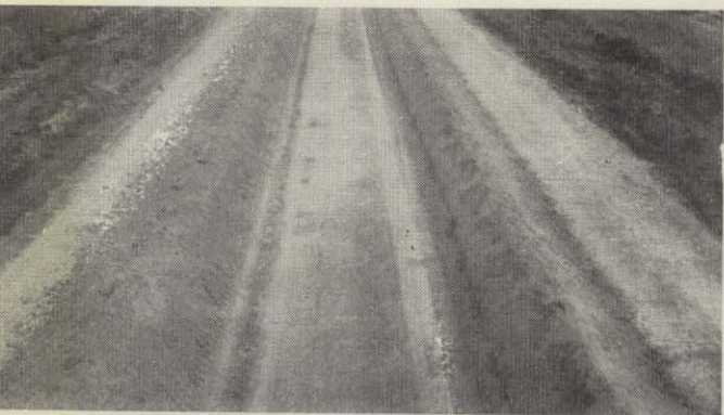
B - 2 Cordones de suelo calcáreo pulverizados
