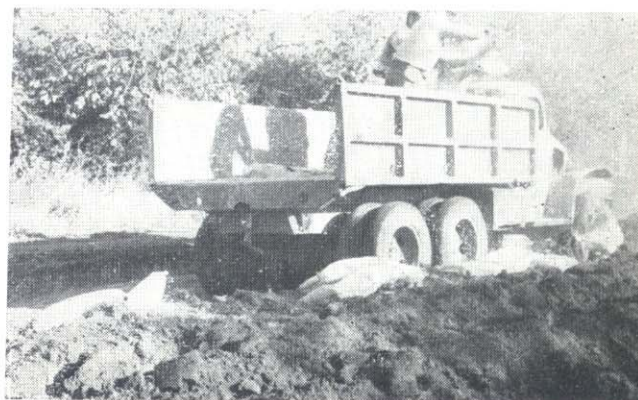
A - 2 Distribución de las bolsas de cal hidráulica.
