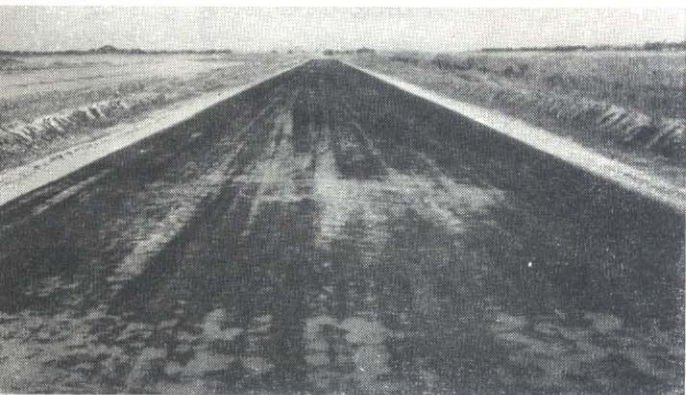
B - 10 Aspecto del tramo terminado.
