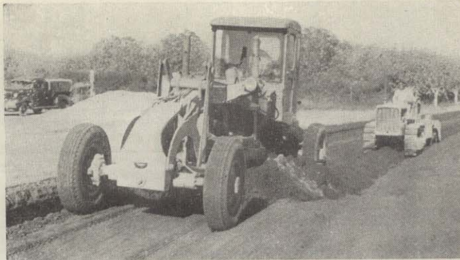
A - 7 Nuevo mezclado y traslado del caballete.
