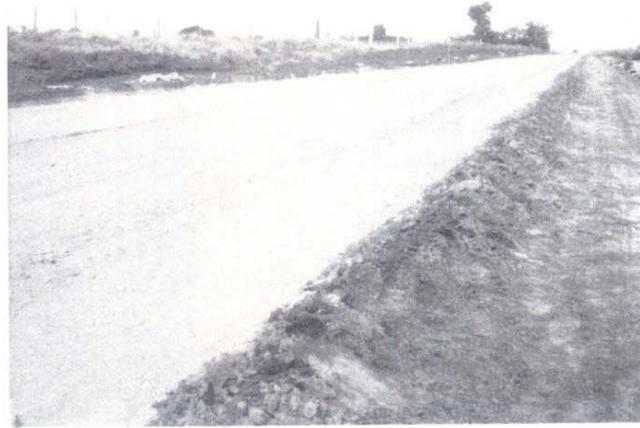
**Aspecto que presenta la calzada con el cemento extendido antes de iniciar el mezclado con el suelo.**
