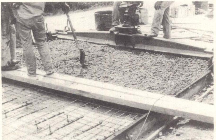
**Compactación del hormigón. Obsérvense la malla y elementos de acero para su fijación.**
