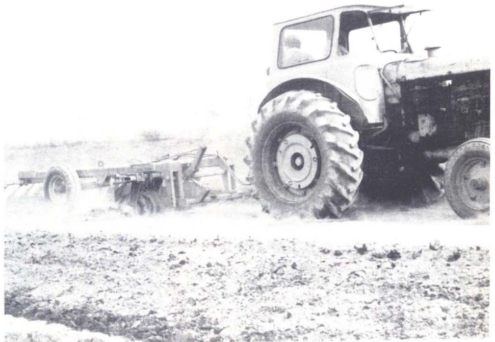
**Mezclado del suelo con el cemento mediante una rastra de discos de tiro excéntrico como las usadas en las tareas agrícolas.**
