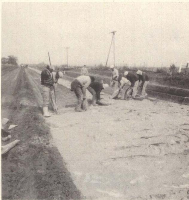
Distribución manual del cemento provisto en bolsas sobre la capa de suelo suelto pulverizado.
