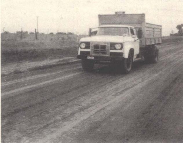
**Tramo recién terminado. Un camión transita sobre el suelo cemento.**
