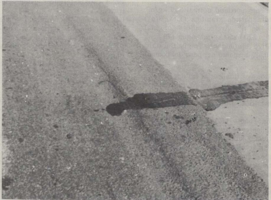
Traza que limita ambas estructuras. Se advierte un ligero solape proveniente de la mezcla en frío, no advirtiéndose fisuras reflejas sobre la misma.
