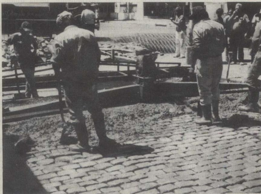
Compactación del hormigón con regla vibratoria en la cuadra experimental de Avellaneda. Nótese en primer plano la armadura de acero.
