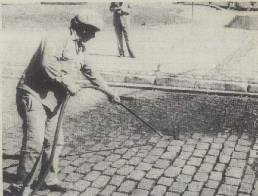
Limpieza de juntas de adoquines con aire comprimido (cuadra experimental de Chilavert).
