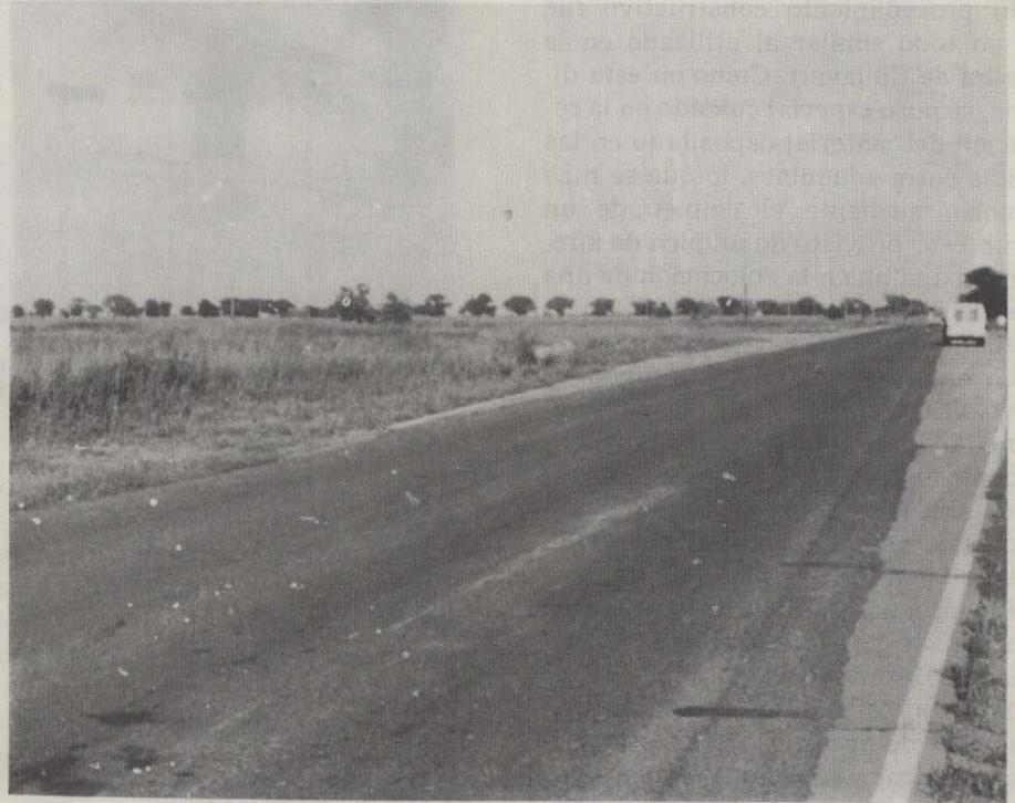
Zona de enlace con la ruta provincial N° 5. Se aprecia la zona de ensanches ejecutada en hormigón.
