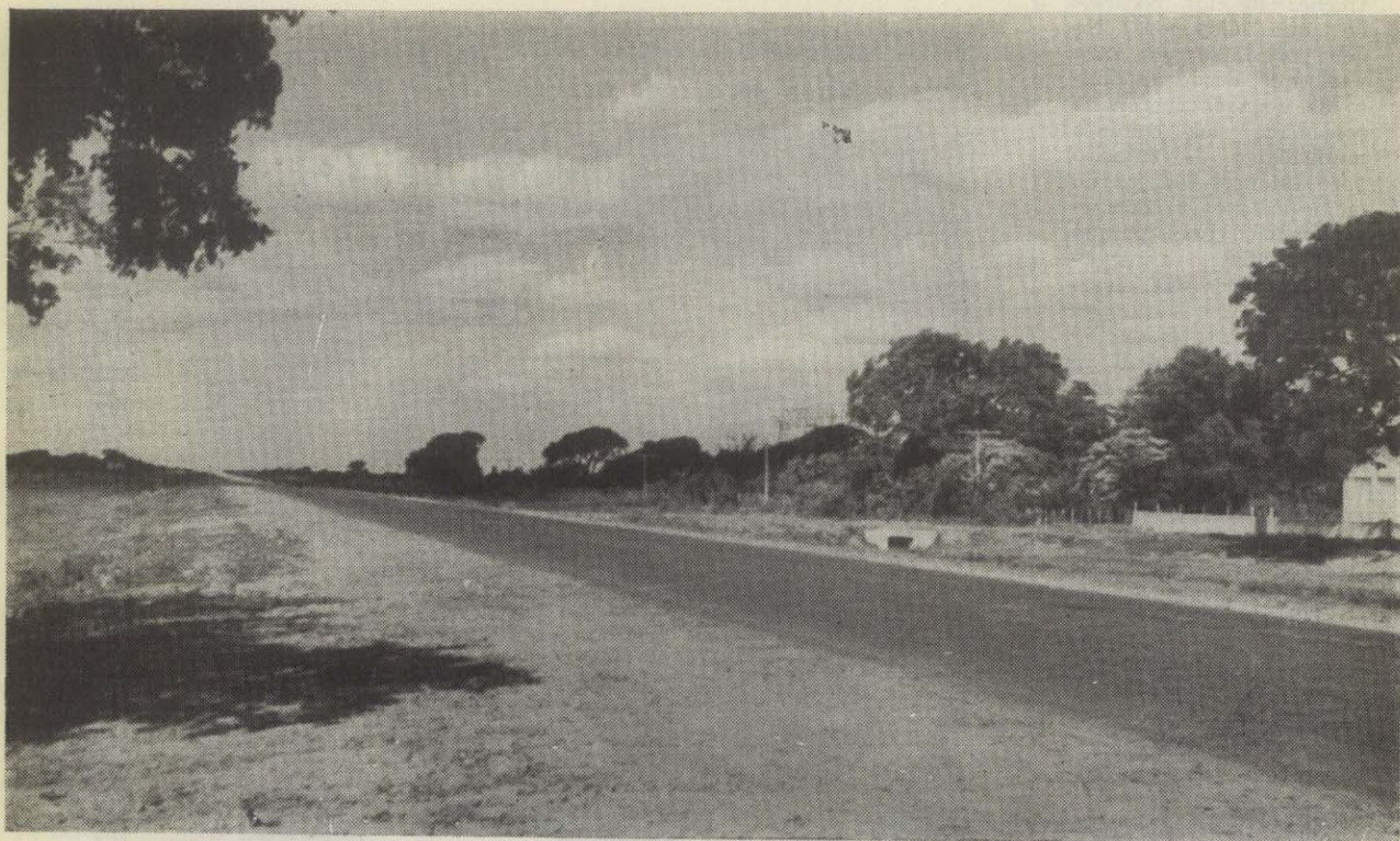
RUTA NACIONAL Nº 12: Tramo Corrientes- Ramada Paso, en la Provincia de Corrientes. Perspectiva de la Carretera hacia Ramada Paso.
