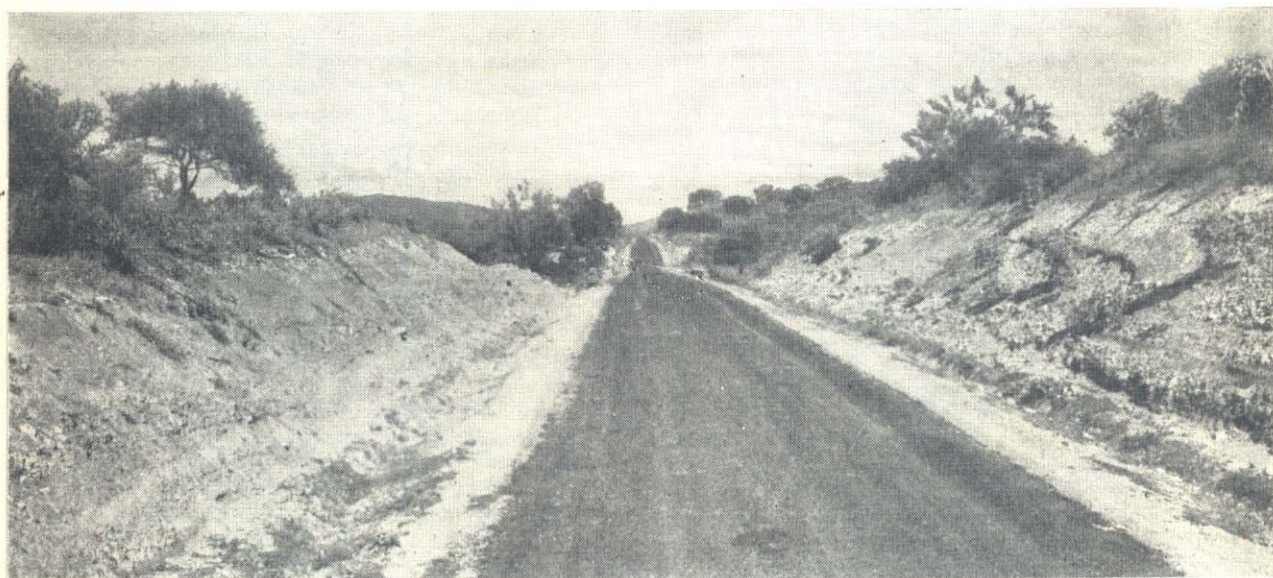
Ruta Nacional 9, provincia de Salta, tramo Río Tala-Rosario de la Frontera. Tratamiento bituminoso sobre enriplado existente
