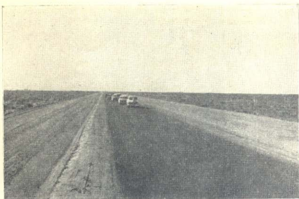
Ruta Nacional 25, Chubut, tramo Rawson-Trelew Tratamiento bituminoso simple.
