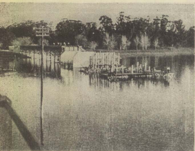
tuta Nacional No. 2 — Capital Federal a Mar del Plata. Puente sobre el río Salado en Guerrero
