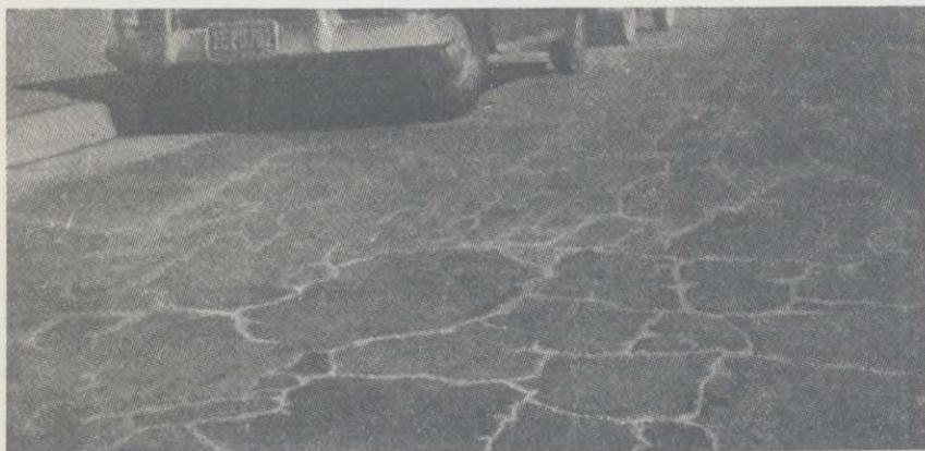
Fig. 3. Agrietamiento de un pavimento quebradizo; no hay evidencia de desplazamiento vertical.
