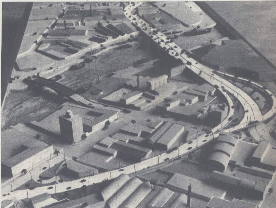
Vista desde Avellaneda. A la izquierda el acceso a Av. Pavón y a la derecha el de la Av. Mitre
