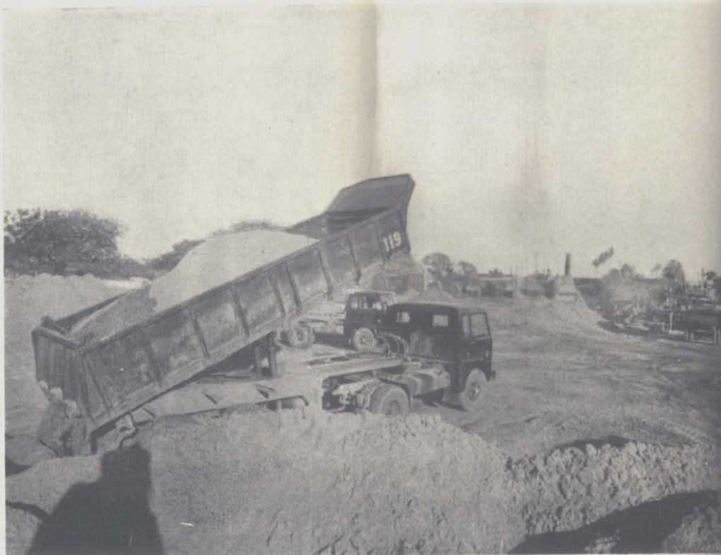
Descargando arena para la usina asfáltica.
