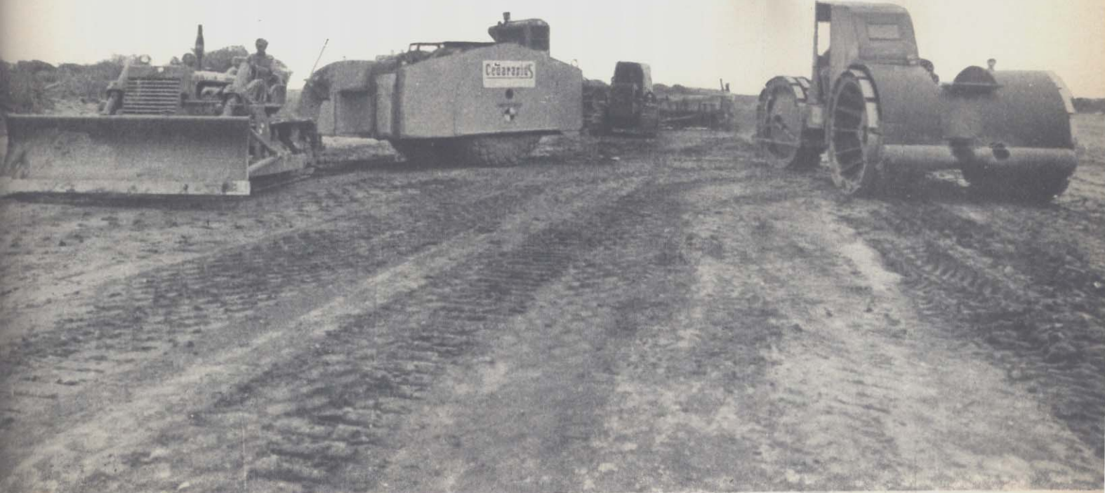
Compactación de base de asiento del terraplén.
