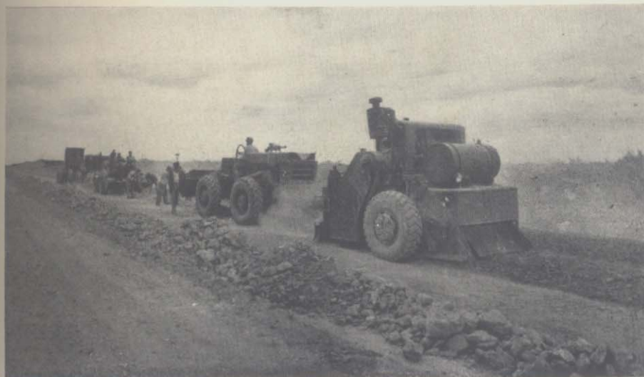
Trituración de tosca en camino, con equipo ambulo-operante.
