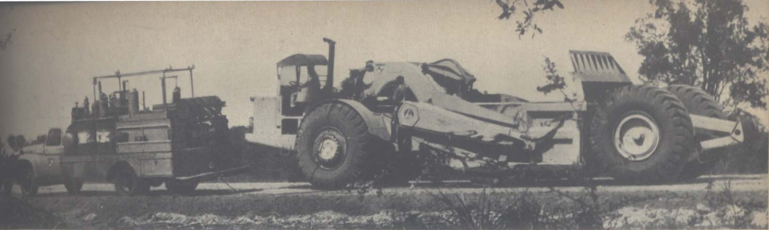
Servicio de engrase en obra.
