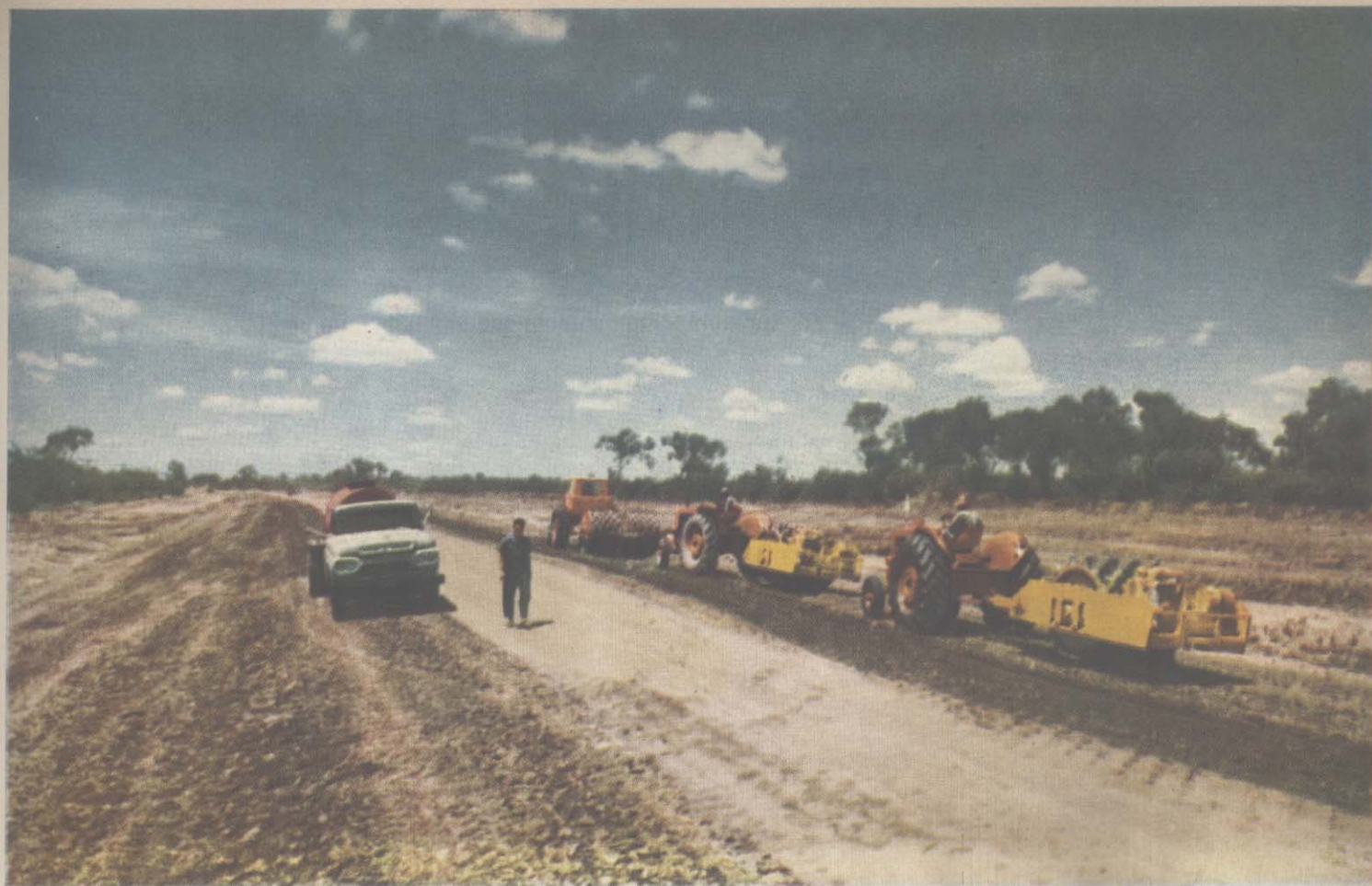
Construcción de terraplenes.
