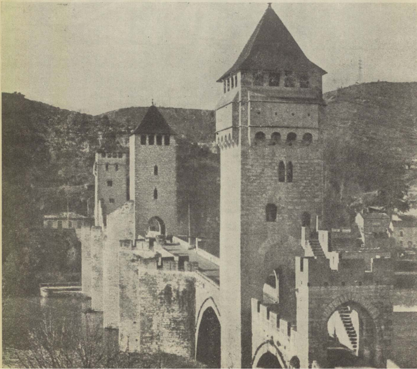
Puente Valentré, en Cahors
