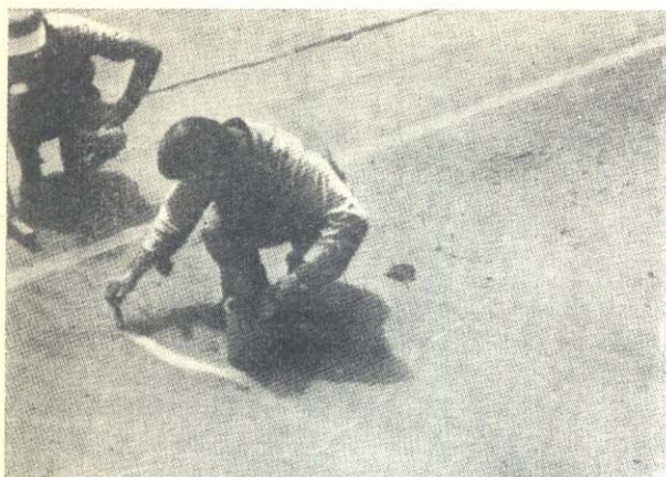
Pintado diario de las fisuras
