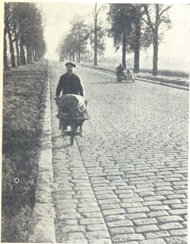
La ruta de Longjumeau, que vió pasar la Posta del Rey...
