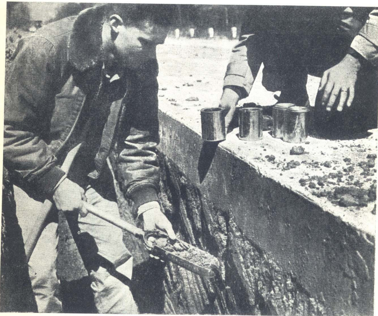
Toma de muestras de suelo debajo de la calzada
