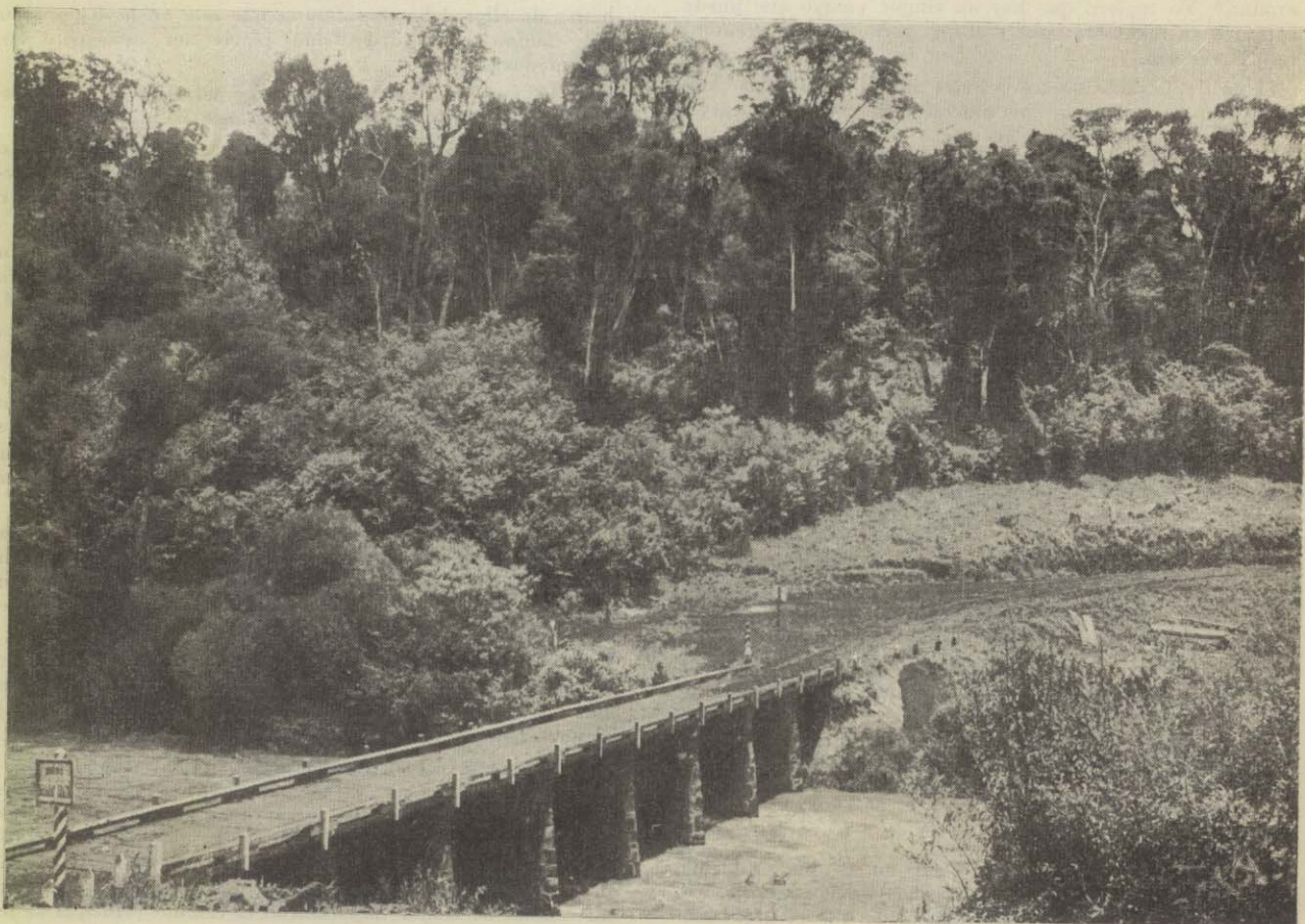
Pasarela sobre el Arroyo Aguaray Guazú en el tramo Eldorado-Cataratas de la Provincia de Misiones
