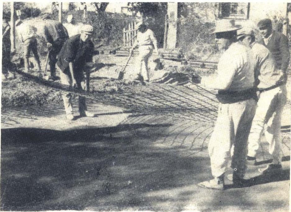
Colocación de la armadura sobre la base de suelo-arena-cemento
