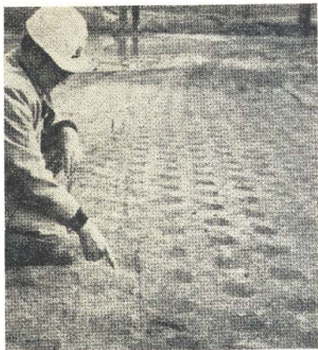
Foto 2. — Las marcas dejadas por el rodillo pata de cabra en el fondo del canal resultaron visibles aún después del año que el canal estuvo en operación.
