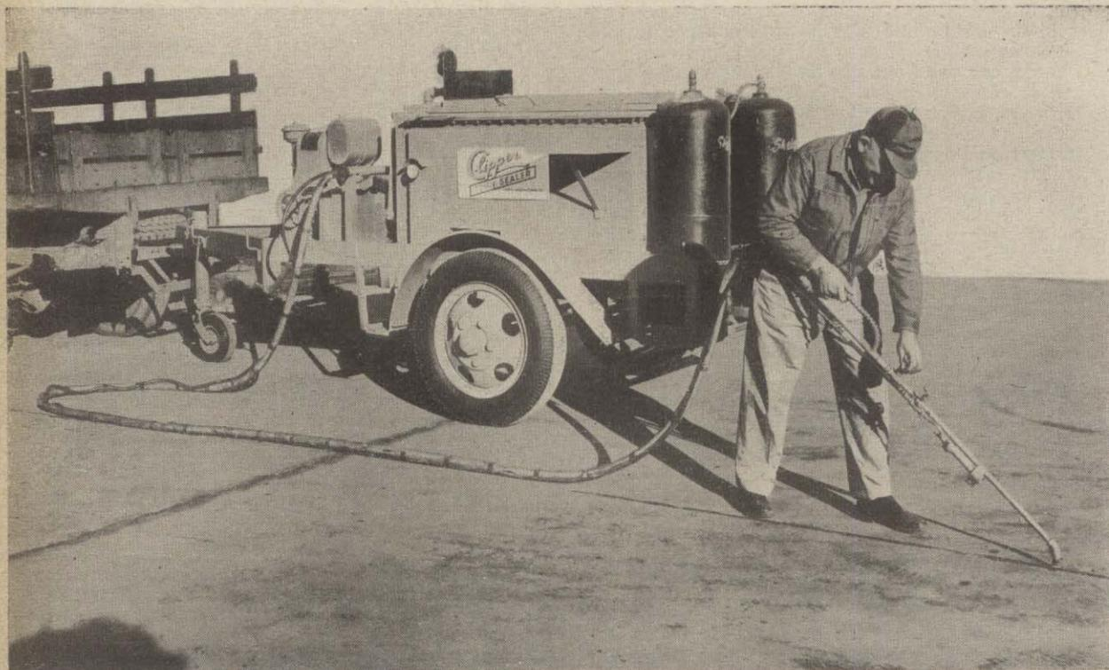
Fig. 4. — Equipo para sellado de juntas con material colocado en caliente.
