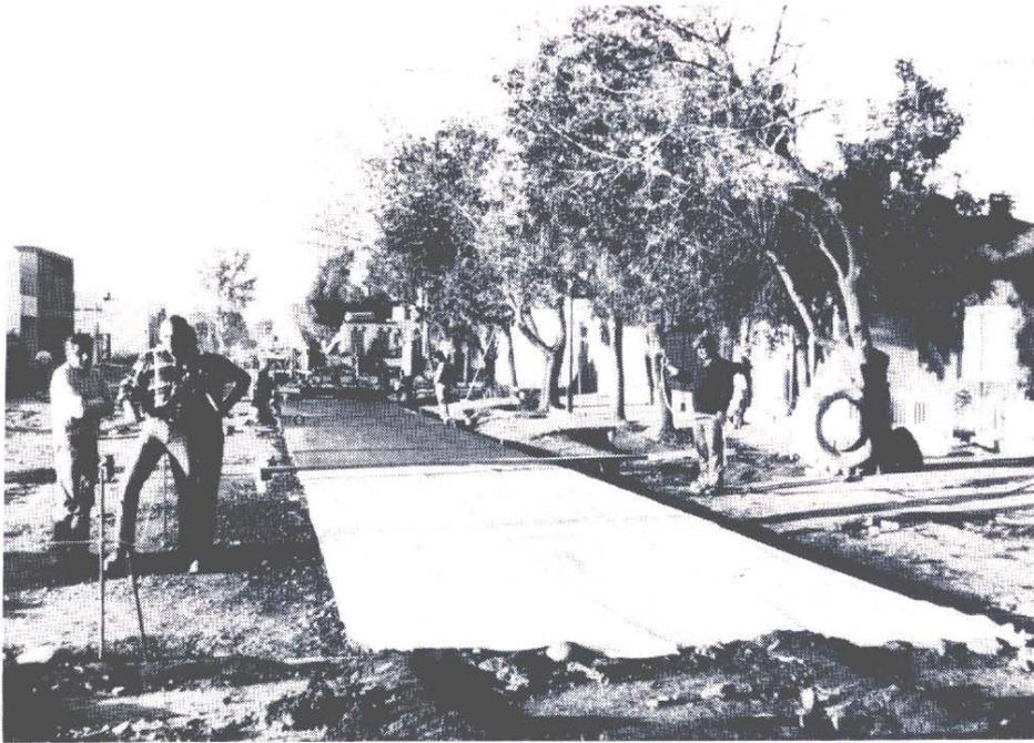
Foto 1. Colocación del hormigón con terminadora de moldes deslizantes.
