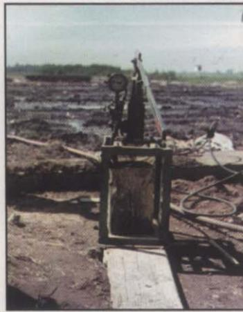
Figura 5: Bomba inyectora de lechada cementicia. Al fondo, curado tradicional
