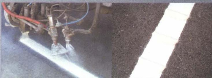
MATERIALES TERMOPLÁSTICOS (APLICACIÓN EN CALIENTE)
