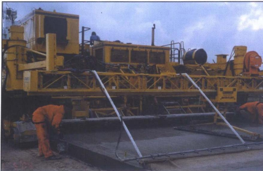
por aserrado se realiza tempranamente, apenas el hormigón adquiere resistencia suficiente para permitir un corte sano de la junta, sin desprendimiento de áridos.
