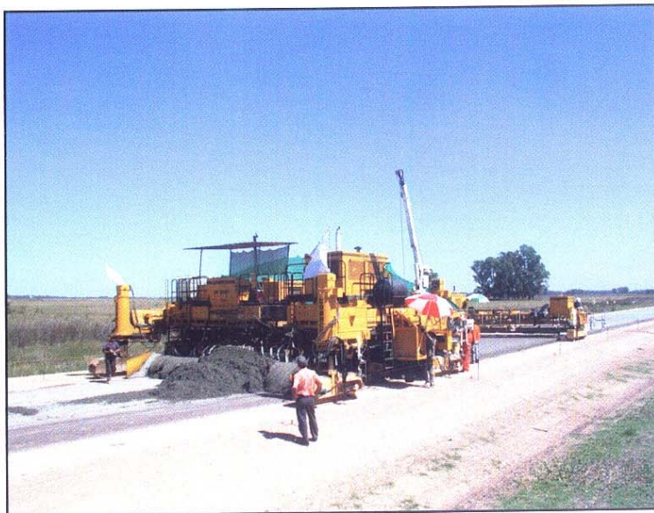
Fotografía N°2: Tren de pavimentación de última generación.
