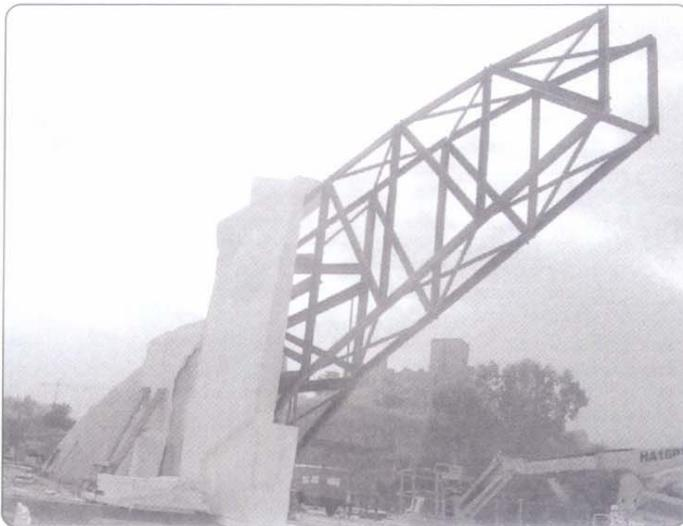
Foto 6. Estructura metálica interna de soporte de la cabeza.
