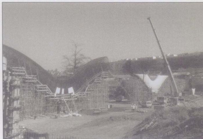
Foto 4. Armazón metálico que conforma la armadura del cuerpo ovoidal del dragón.
