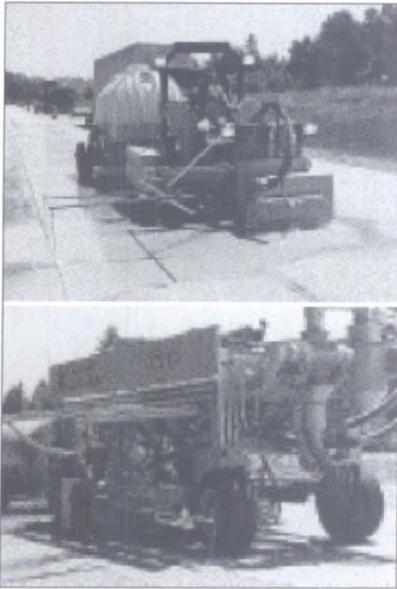
Figura 1 - Máquinas que permiten el aserrado de 3 y de 6 ranuras a la vez. Una vez cortadas, puede restablecerse el tránsito
