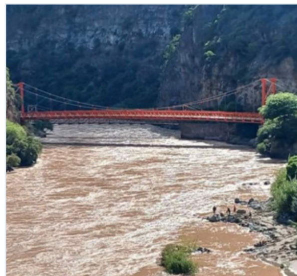
FIGURA 6 Puente de la Ruta 3S, en el río Apurímac.
