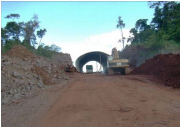
Imagen 20. Etapa constructiva del primer ecoducto o pasafauna superior construido en Argentina, entre 2007 y 2008. Este ecoducto se encuentra en la Ruta Nacional N° 101, en la provincia de Misiones, en un tramo que atraviesa un corredor biológico que conecta dos áreas naturales protegidas, situadas en uno de los bloques más importantes de la ecorregión Selva Paranaense que se conserva en nuestro país. Fotos: Diego Varela.
