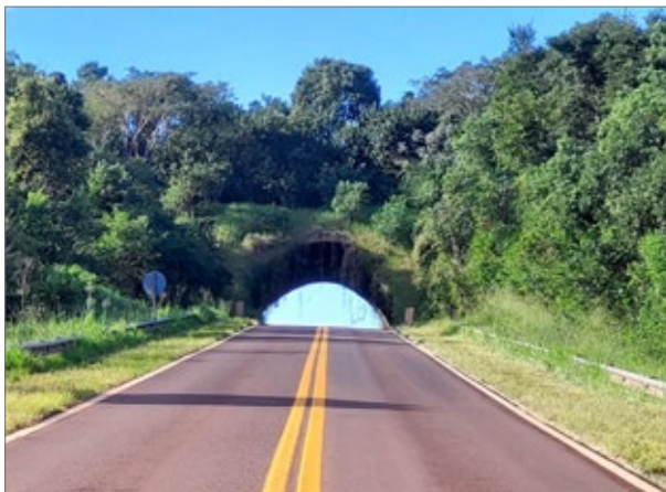
Imagen 16. Pasafauna superior o ecoducto. Ruta Nacional N° 101. Foto: Diego Varela.
