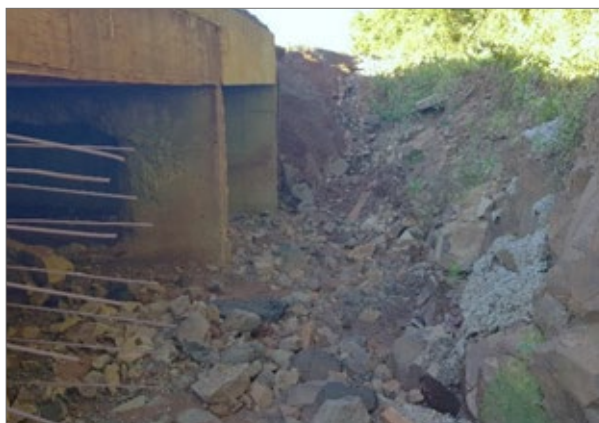
Imagen 22. Etapa constructiva de un pasafauna subvial cuyo emplazamiento requirió la realización de desmontes en roca y la posterior conformación de una capa edáfica para lograr la revegetalización y asegurar la funcionalidad de la estructura. Fotos: DPV de Misiones.
