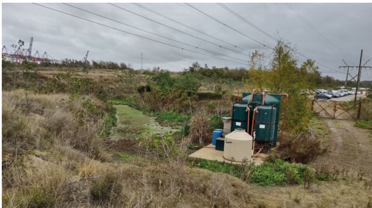
Imagen 7. Sistema de tratamiento de efluentes de procesos.
