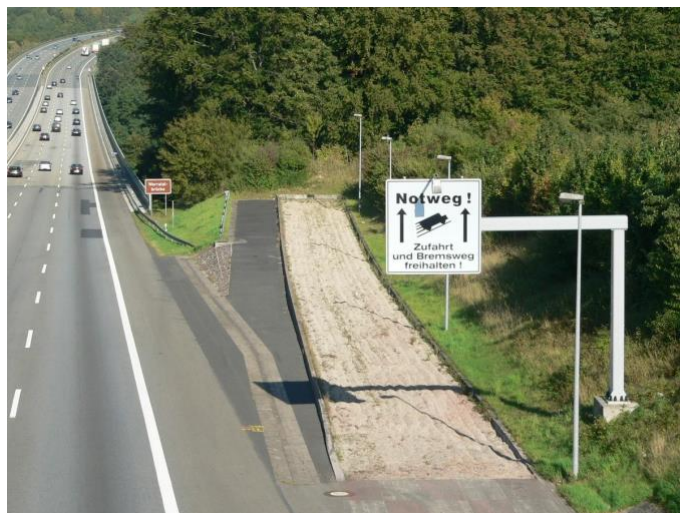
Imagen 4. Rampas de detención de emergencia.
