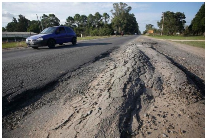
Imagen 1. Reacondicionar la calzada.
