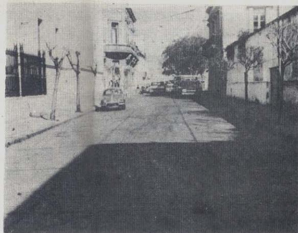
tada en 1921. Este pavimento estaba constituido por una base de hormigón pobre de 20 cm. de espesor y una carpeta asfáltica. El suelo de la subrasante es de tipo limoso, sin plasticidad, con bajo valor portante.
