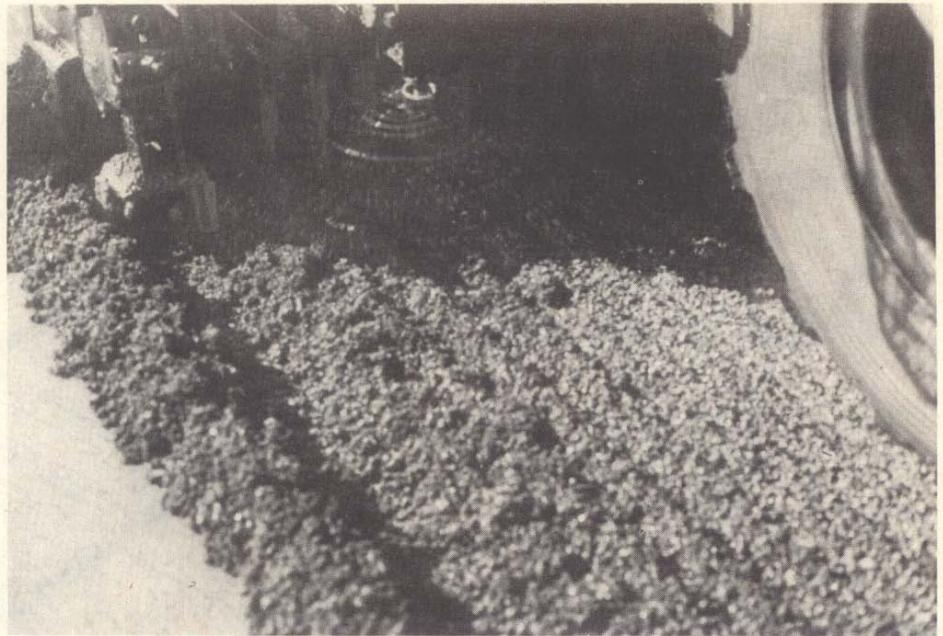
Figura 5. Mezcla escarificada en caliente y aplicación de la emulsión modificadora.
