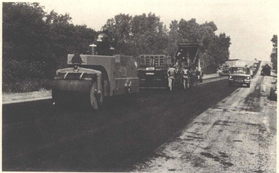
Figura 3. Trabajo conjunto de la repavimentadora 2500 (atrás) y la recicladora 2000 (adelante).
