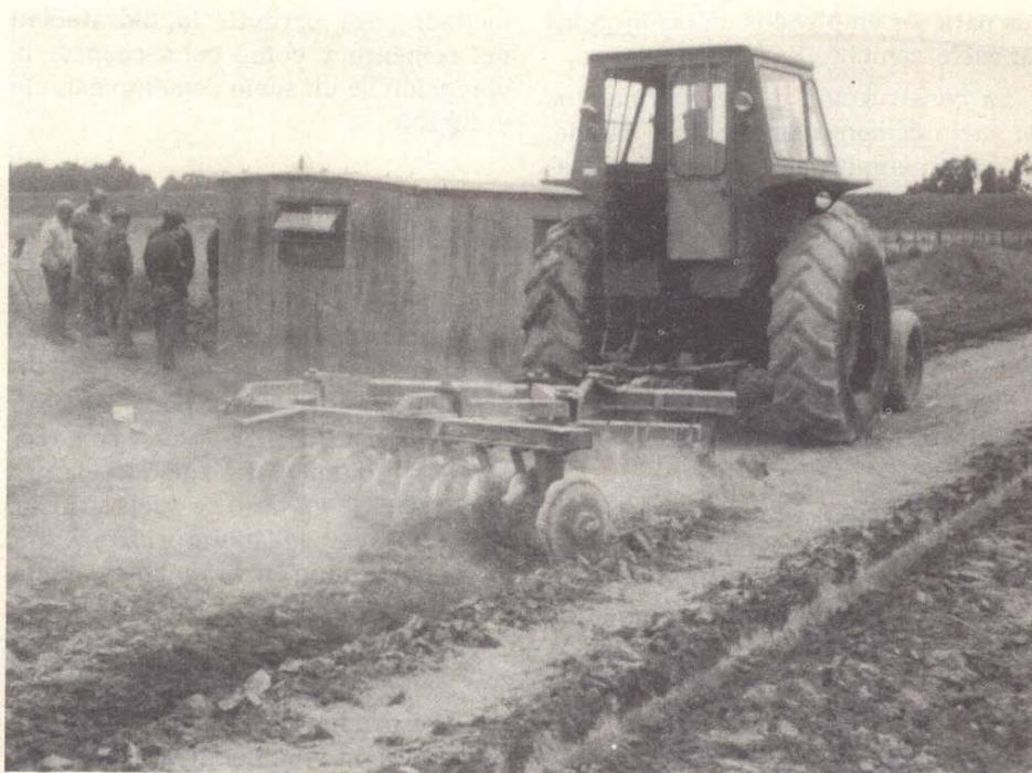
Con una rastra de discos de dos cuerpos, utilizada también para la pulverización del suelo, se mezcla el suelo con el cemento.
