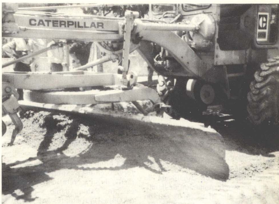
Foto 3. Detalle de distribución con motoniveladora. Lanús.
