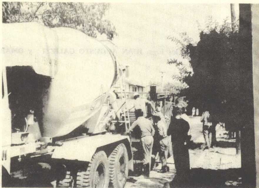
Foto 1. Alimentación con motohormigonera del equipo distribuidor. San Martín.
