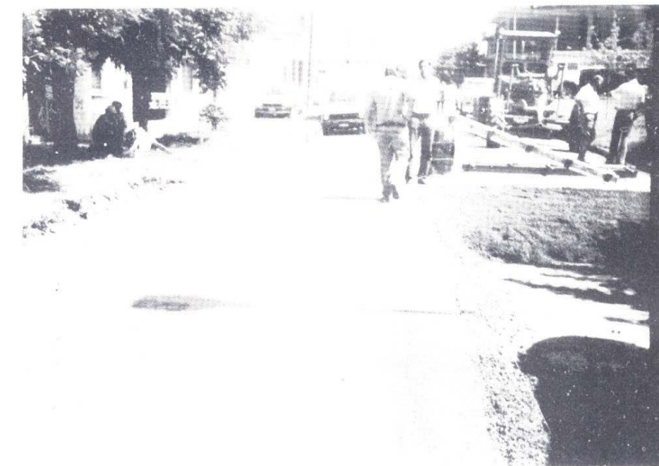
Foto 4. Vista general del bacheo en ejecución; observar junta longitudinal central. Lanús.
