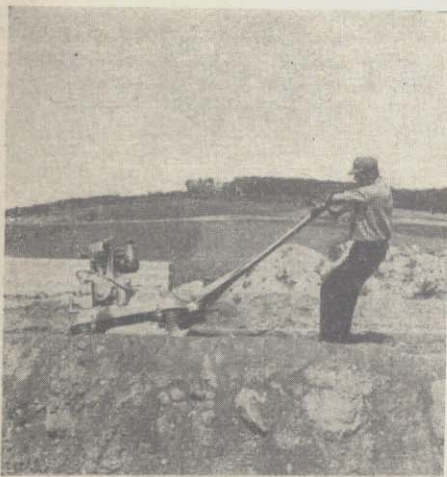
Compactadora vibratoria manual, trabajando en una variante de camino, en Alemania Occidental. Este tipo de compactadora, permitiría abreviar las tareas de reparación de zanjos para conducciones, que tanto afectan las aceras y calles de nuestras ciudades. (Foto del autor).
