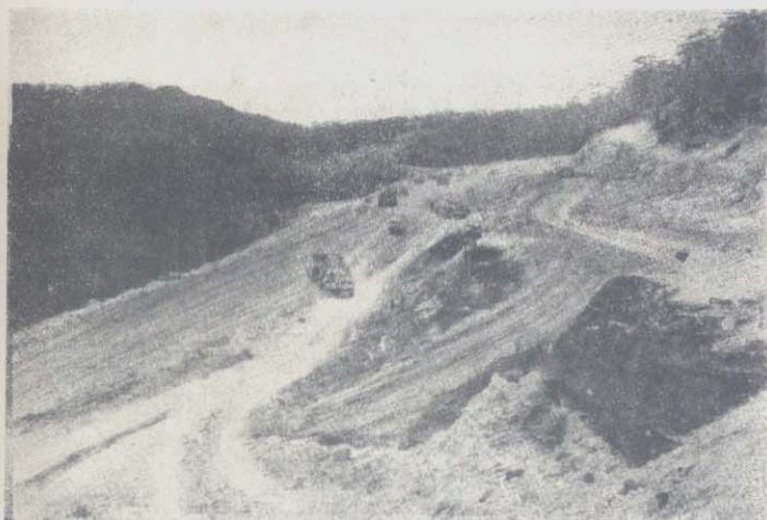
Una vista general de los trabajos en el primer tramo de la autopista entre Sydney y Newcastle.
