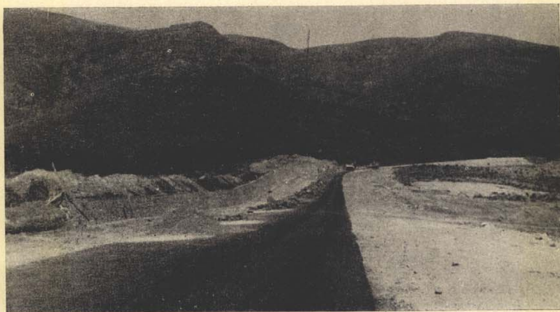
Ruta construida en la zona de Abra de la Vca'ana
