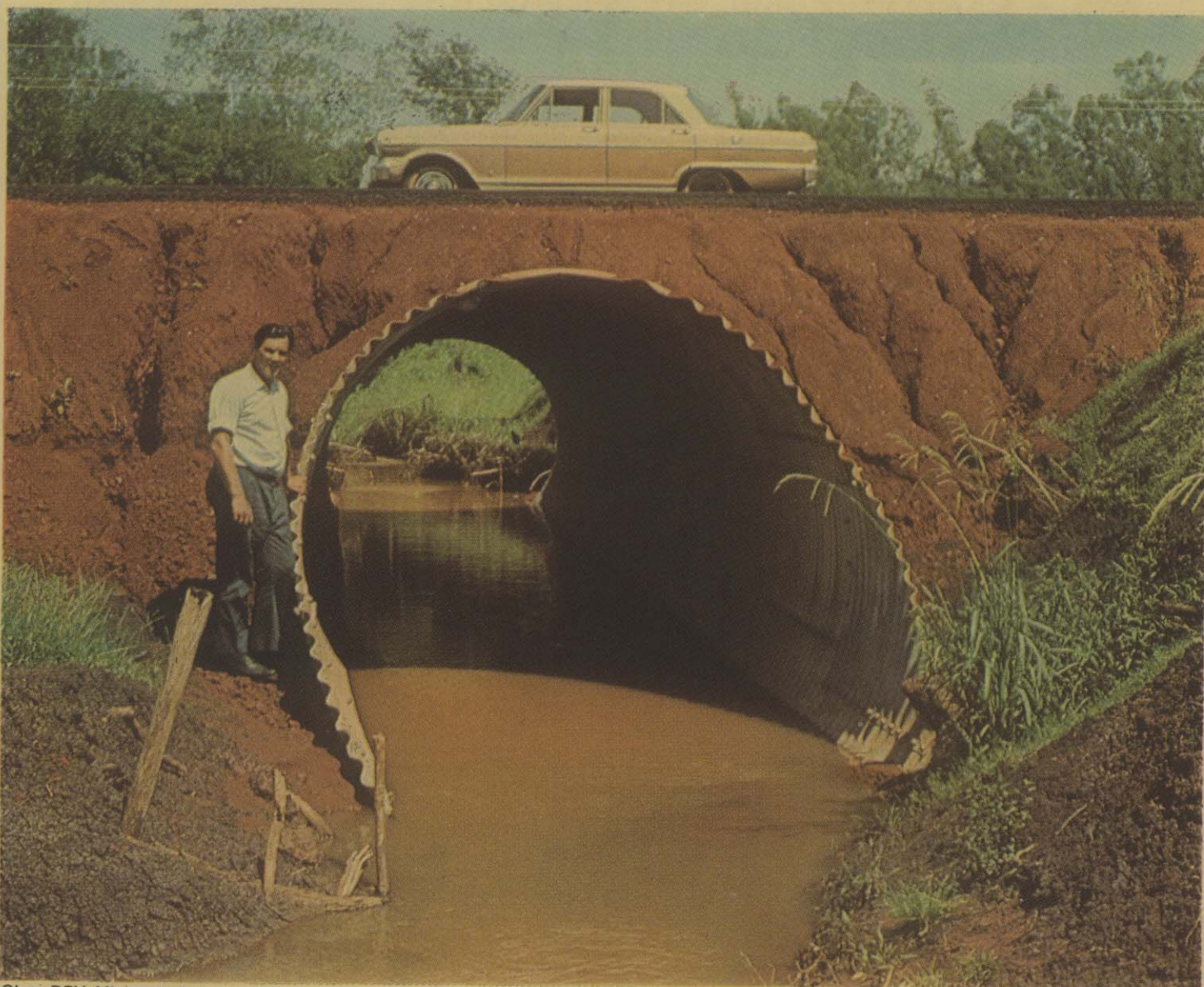
Obra DPV Misiones Ruta N° 1 Tramo San José - Apóstoles
