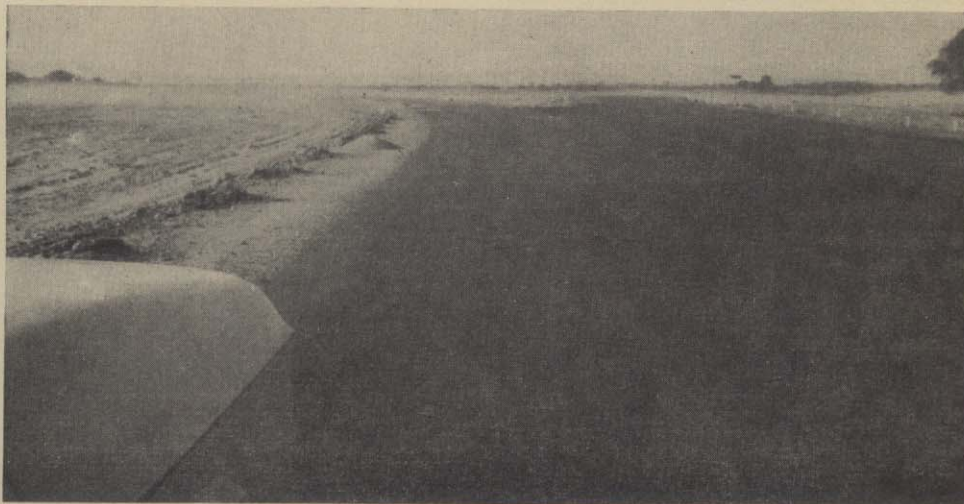
Aspecto general del tramo Sumalao - San Martín de la Ruta Provincial N° 33, recientemente inaugurado.
