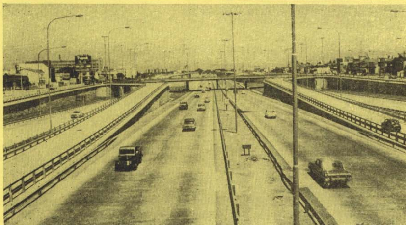
Aspecto parcial del tramo ensanchado de la Avda. General Paz.
