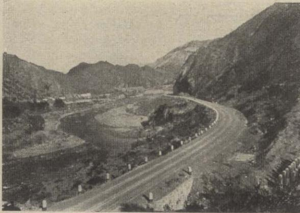
MENDOZA. Un aspecto del tramo entre Potrerillos y la Quebrada del 60. Camino en faldeo y corte en roca con mojonos de seguridad.
