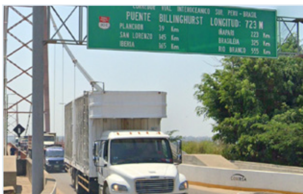
FIGURA 12 Puente Billinghurst en Puerto Maldonado.
