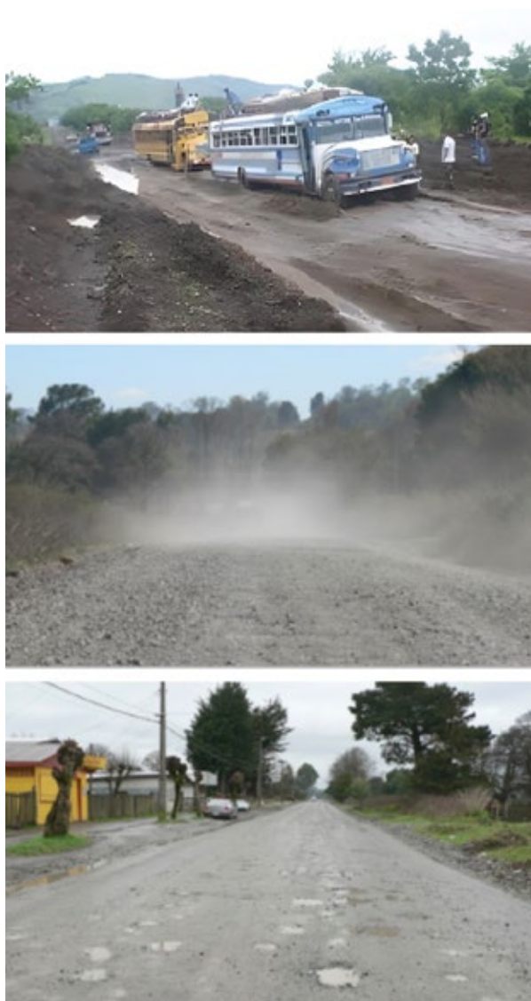
Figura 4. Deterioro funcional y estructural en caminos de bajo volumen de tránsito.
