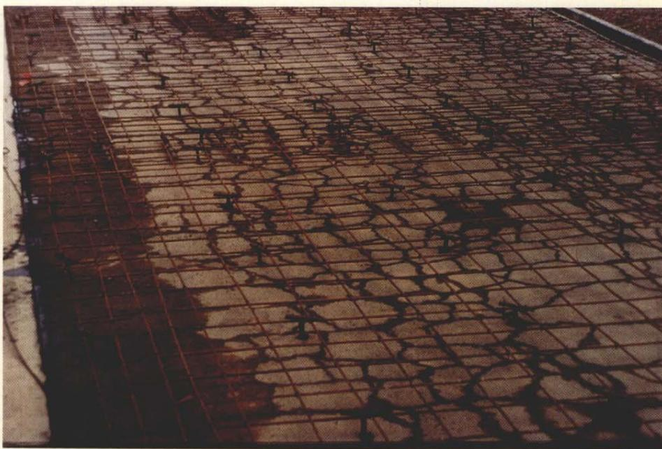
Fig. 4: Vista del agrietamiento y ahuellamiento del pavimento existente con la malla en posición. (Calle 31 - La Plata)
