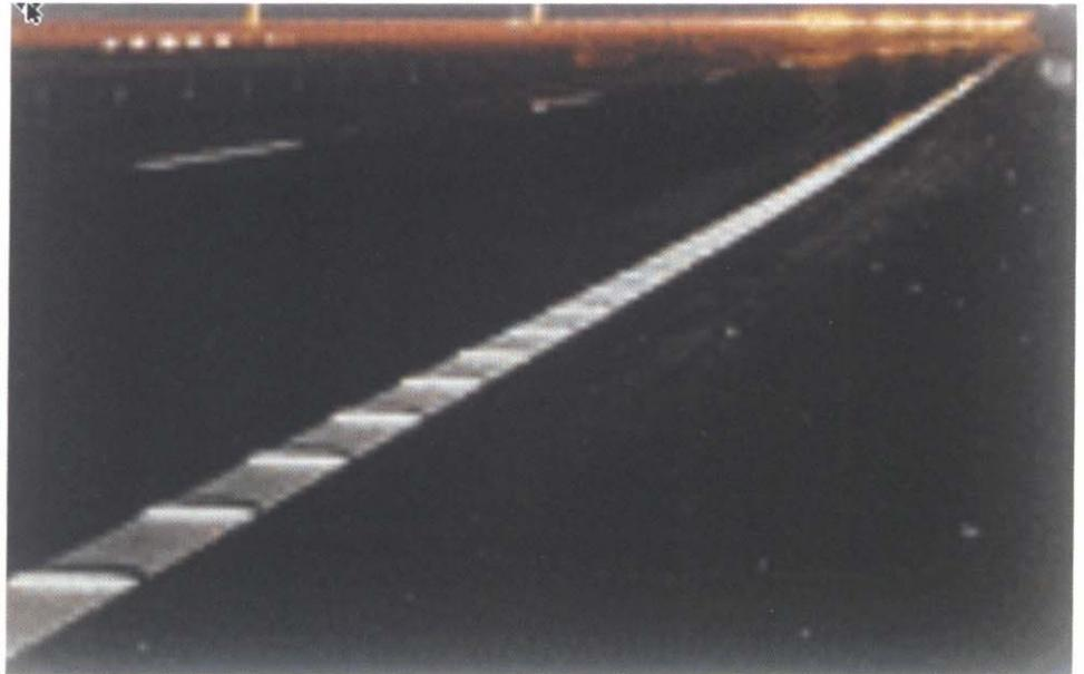
una superficie rugosa que facilita el drenaje del agua sobre su superficie y que, al mismo tiempo, provee al sistema de puntos emergentes (resaltes) sobre la película de agua que mantienen sus propiedades de retroreflexión incluso en condiciones de lluvia intensa.
