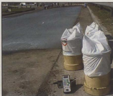
Fotos 4 y 5: Protección del pavimento con mantas térmicas.
