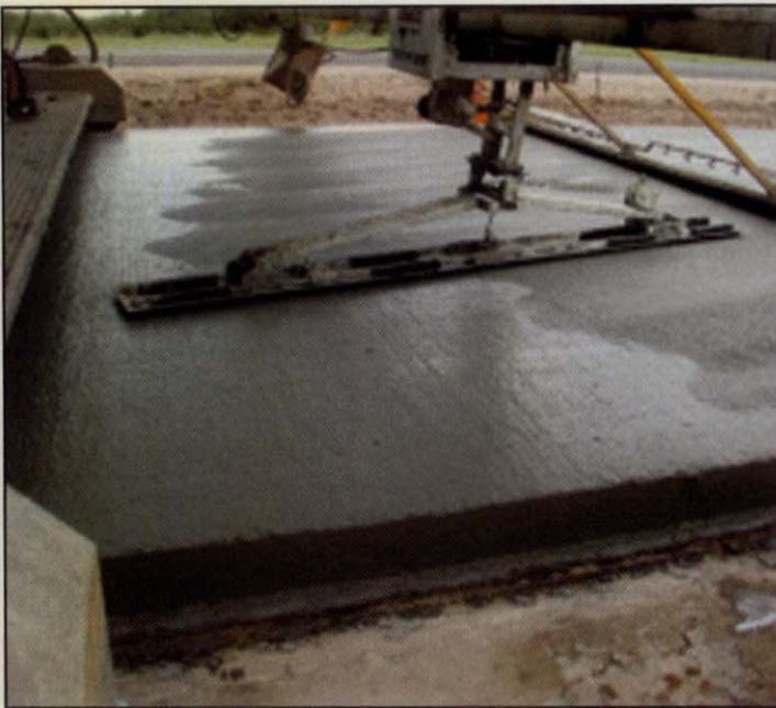
Fratás automático de la pavimentadora
