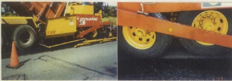
FIGURA N° 6: Fotos del levantamiento del riego de liga por parte del tránsito de obra.
