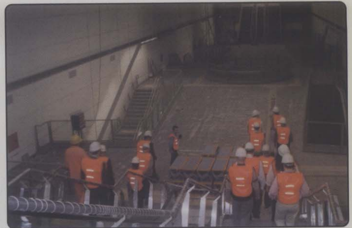
Visita a la línea H del Subterráneo Metropolitano, actualmente en construcción
