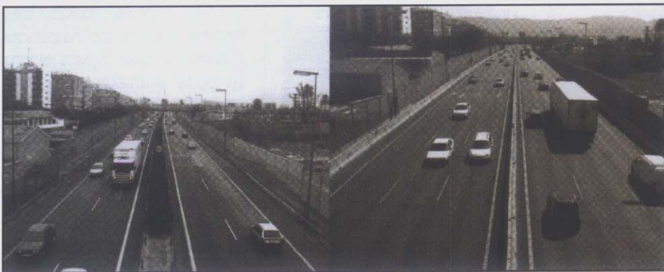
Visiones comparativas de un tramo de autovía antes y después de una ampliación
