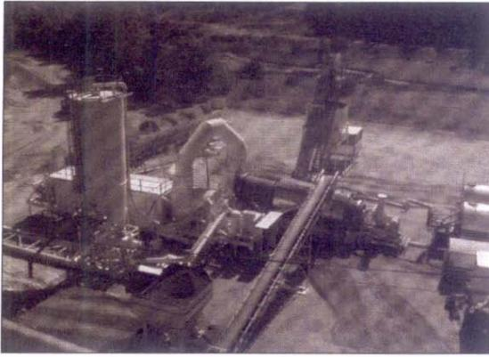
Foto 2. Planta continua Double Barrel (ASTEC).
