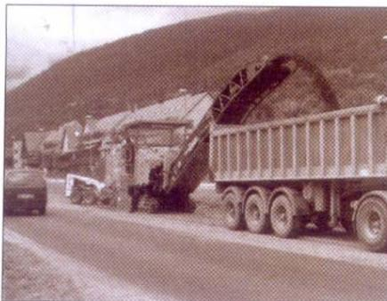
Foto 3. Fresado previo a la incorporación en planta
