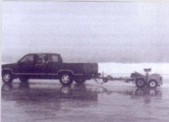
Foto 3. Medición del rozamiento en condiciones invernales.
