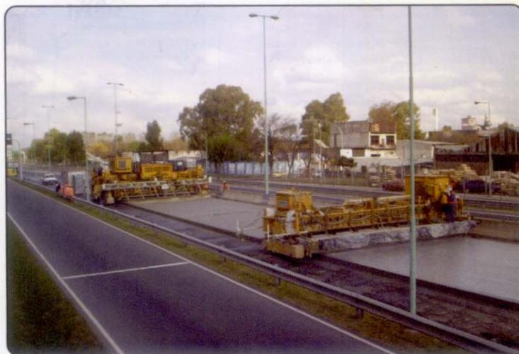
Foto N°2: Ejecución de Rehabilitación de Autopista Héctor J. Cámpora (AU7). C. A. B. A.
