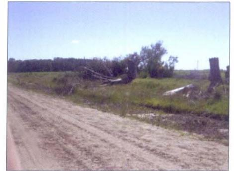
Foto N°5 - Desagüe longitudinal obstruido por ramas y malezas
