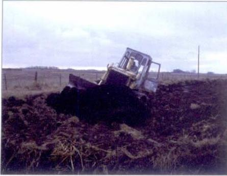
Foto N°3 - Alteo con extracción lateral
