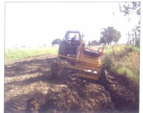
Foto N°6 - Reconstrucción con extracción lateral (niveladora de arrastre), mejora del rendimiento en zonas puntuales.
