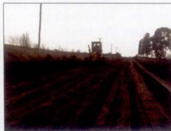
Perfilado con Extracción Lateral
