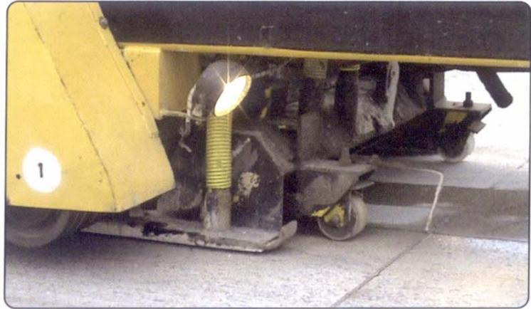
Foto N°3: Pulido con discos diamantados de pavimentos de hormigón.
