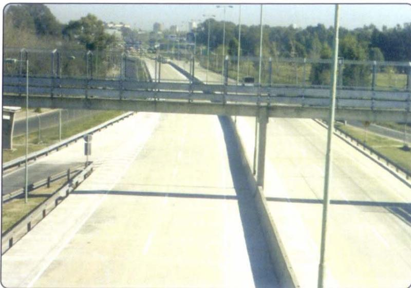
Foto N°1: Calzada de hormigón con banquina de hormigón externa e interna.
