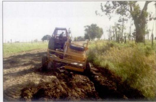
Foto N°8 - Construcción de alcantarilla lateral tipo caño (de cruce con otra vía de comunicación) para mejorar el drenaje longitudinal del camino.
