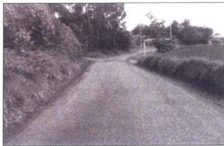
Foto 5. Aspecto final de la obra después del doble engravillado
