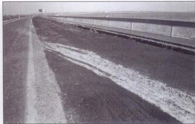
Foto 1. Aspecto típico de una imprimación con una ECI sobre un soporte granular cerrado
