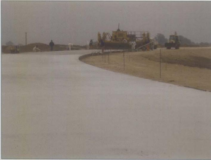
Una pavimentadora de encofrados deslizantes de menor porte, sin DBI, y con fratasado manual se utiliza en la construcción de ramas en distribuidores (foto tramo Chediack – Esuco)
