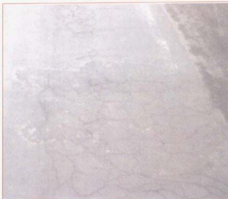
FISURACIÓN (SIN HUNDIMIENTO), A RESOLVER CON MEMBRANA ARENA-ASFALTO
