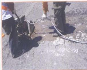
visual, midiendo los espesores de capas ligadas y comprobando, además, su estado y características. Se verificaron los bordes y los sobranchos para apoyo de las capas estructurales.
