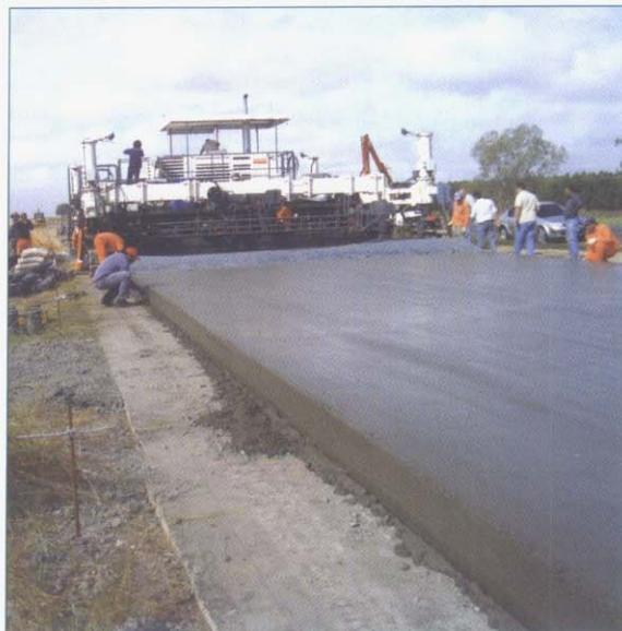
Foto 1: El sobrancho de la subbase provee una superficie adecuada para la tracción de la pavimentadora. RN N°14. Pcia. de Entre Ríos.
