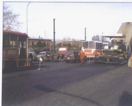
Figuras 7 y 8. Tramo de prueba de mezcla tibia. Mezcla tipo SMA.
