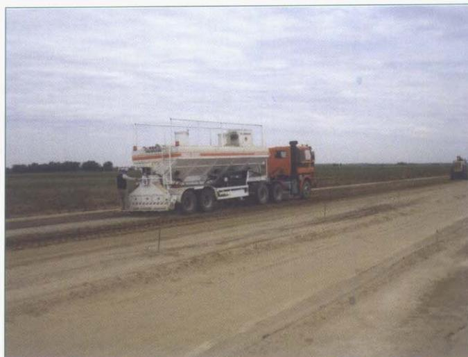
Modernos equipos cortadores de cancha (trimmers) y distribuidores de cemento en la construcción de bases de suelo cemento (fotos tramo Iecsa)
