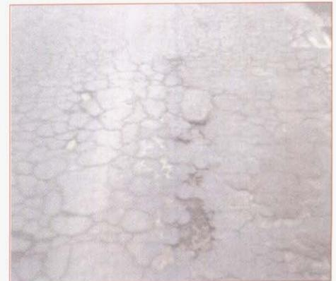
BACHE (FUERTE FISURACIÓN, DESPRENDIMIENTO Y/O HUNDIMIENTO)
