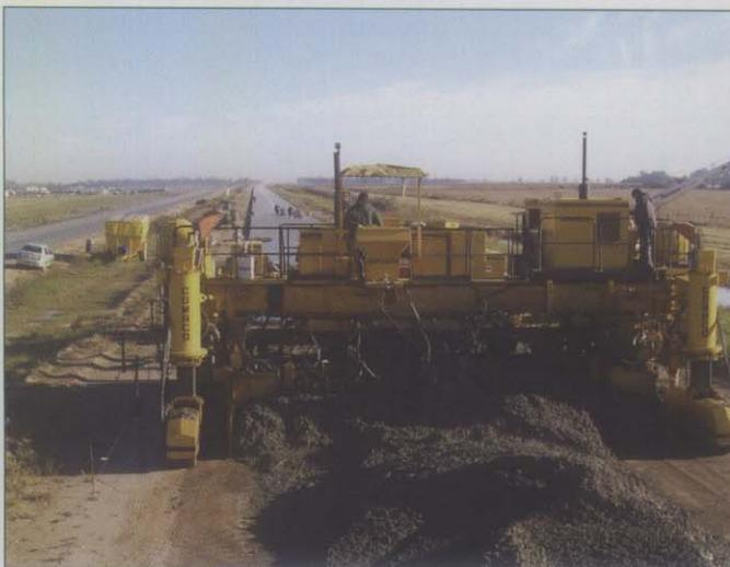
4 pavimentadoras de encofrados deslizantes de última generación, trabajando en ancho completo, con DBI y autofloat, construyen hasta un kilómetro de pavimento de hormigón por jornada (foto tramo Roggio)
