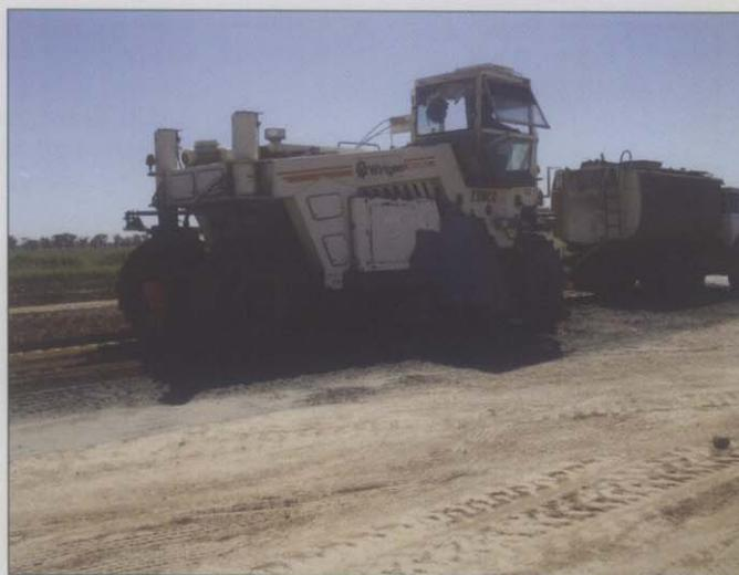
El uso de recicladores de elevada potencia y producción permite construir los 5,4 millones de metros cuadrados de suelo cemento previstos en el proyecto, con la calidad y celeridad que requieren las TAR (foto tramo Chediack - Esuco)
