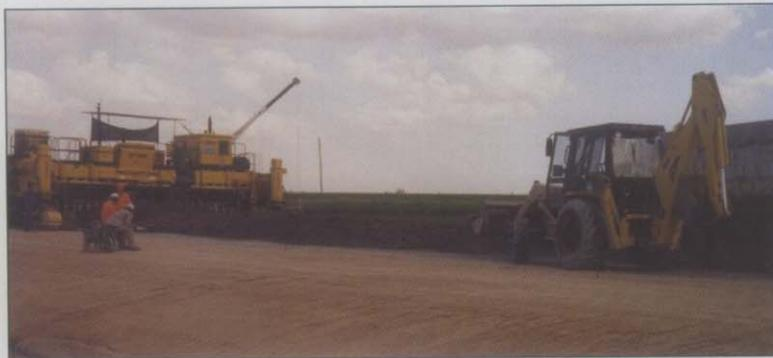
Foto 3: Tren de pavimentación utilizando descarga controlada con el apoyo de una retropala. Autopista Rosario - Córdoba. Pcia. de Santa Fe
