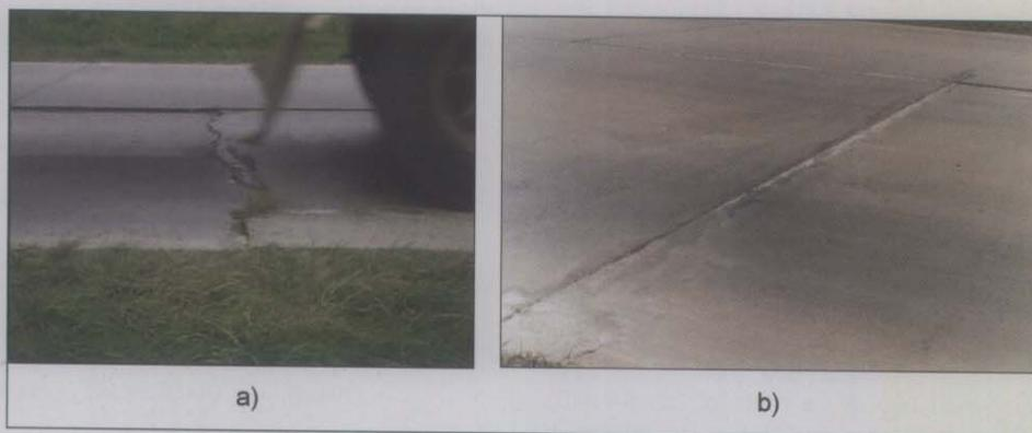
Figura 8. a) Bombeo en una fisura transversal de alta severidad, con eyección de material líquido. b) Sello deteriorado y elevado escalonamiento en una junta transversal
