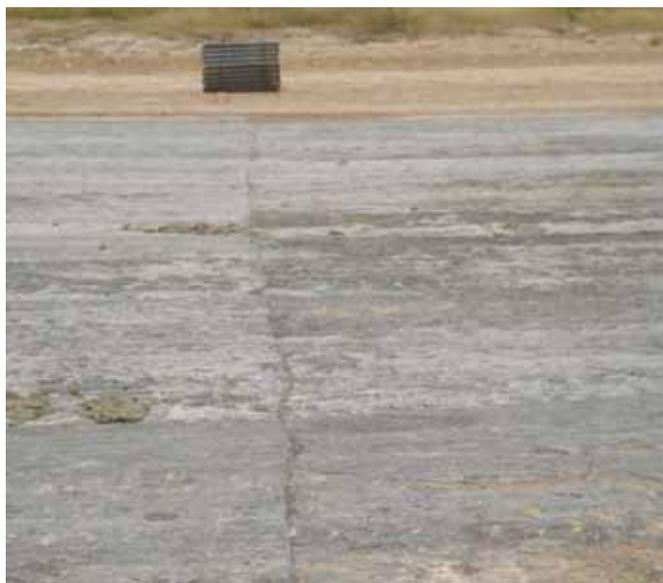
Foto 9: junta de construcción bien resuelta, se genera un plano vertical bien definido
