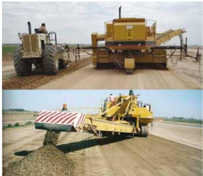
Foto 8: Trimmers en la construcción de bases cementadas
