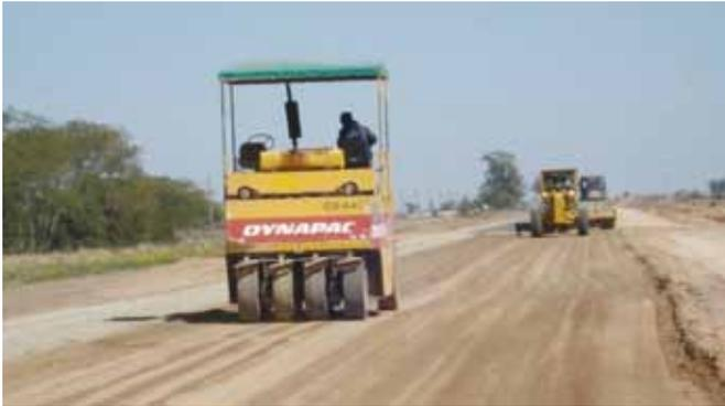
Foto 7: Sellado final con rodillos neumáticos
