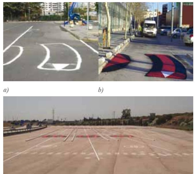
Figura 3. Experimentación del **Speed Kidney**: (a) Prueba preliminar, (b) Implementación real, (c) Pista de ensayos
