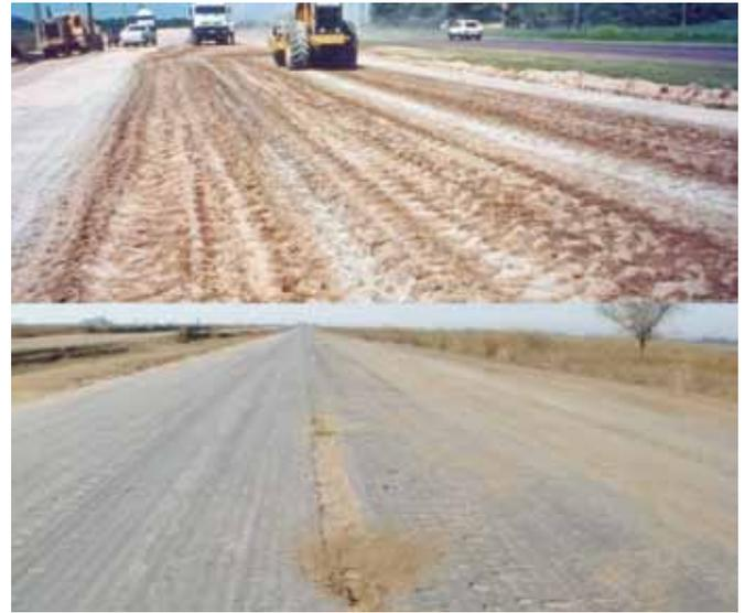
Foto 5: La falta de solapes adecuados entre las distintas fajas de trabajo del reciclador, puede generar juntas longitudinales de material sin tratar
