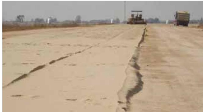
Foto 2: Distribución de arena con extendedora de asfalto
