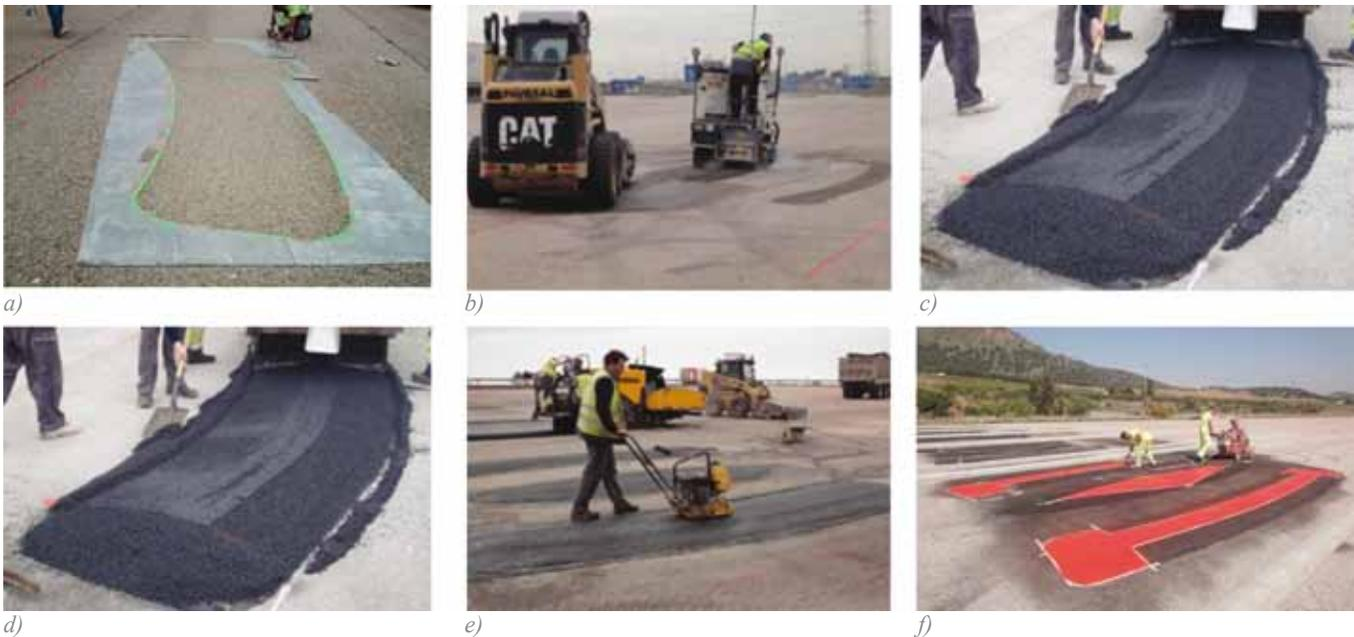
a) b) c) d) e) f) *Figura 13. Proceso constructivo: (a) Replanteo, (b) Corte, (c) Fresado, (d) Extendido, (e) Compactación, (f) Pintura*
