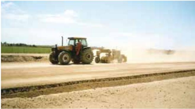
Foto 10: barrido y soplado de la superficie, previo al riego de curado
