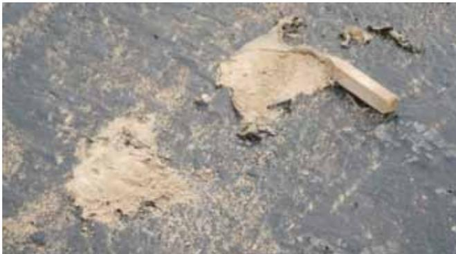
Foto 11: curado efectuado sobre la superficie seca y mal preparada
