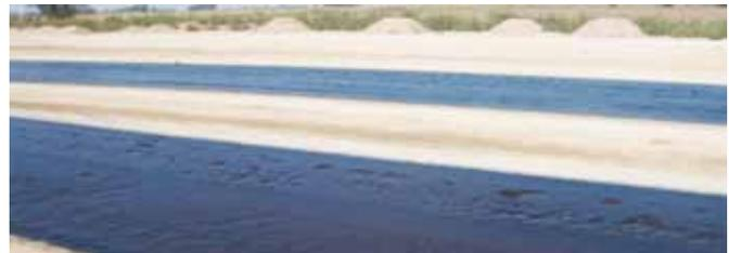
Foto 12: canchas de suelo cemento terminadas y curadas
