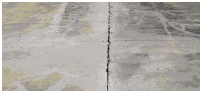
Foto 9: Aserrado muy prematuro, produce desprendimientos de áridos, y posteriormente dificultad para el sellado y bordes débiles durante el uso.
