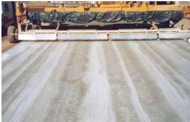
Foto 8: La pigmentación blanca permite apreciar falta de uniformidad en el riego
