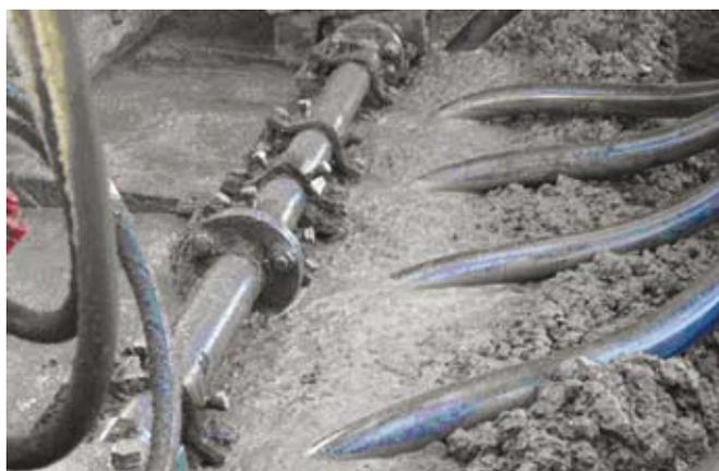
Foto 6: Efecto de la vibración del hormigón que poseía aspecto algo pedregoso
