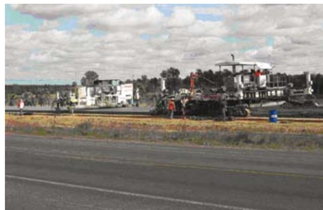
Foto 7: Equipo de curado marchando inmediatamente detrás de la pavimentadora
