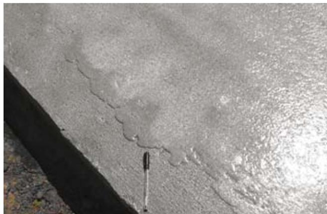
Foto3: Exudación excesiva, puede generar caídas de borde y falta de adherencia de la membrana en la zona afectada.
