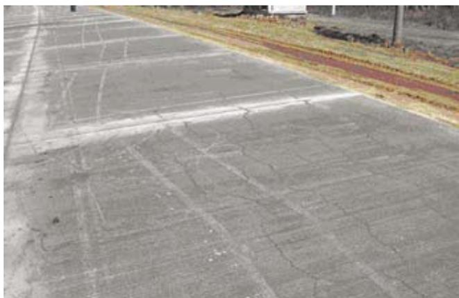
Foto 4: Deficiencia en fisuras plásticas
