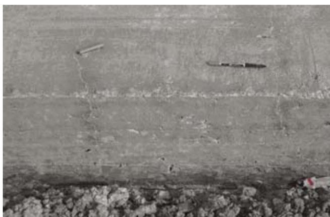
Foto 5: Marcas de borde por enfriamiento rápido del borde (0) que recibió varias horas de sol. horas de sol..
