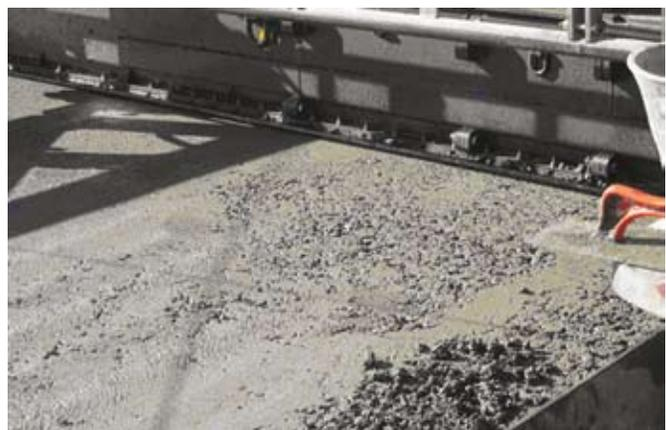
Foto1: Deficiencia en la trabajabilidad, provoca defectos de colocación y pérdidas de resistencia
