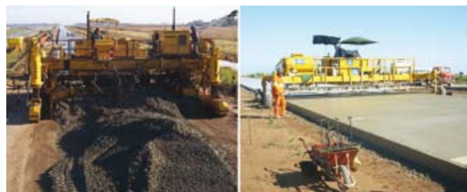
Figura 23 – Construcción de la Autopista Córdoba - Rosario
