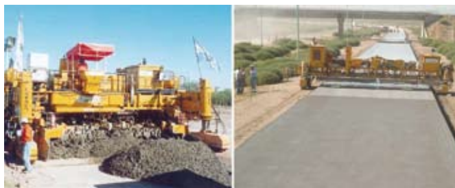
Figura 9 y 10 – Construcción de la Autopista Ruta Nacional N°7. Provincia de San Luis
