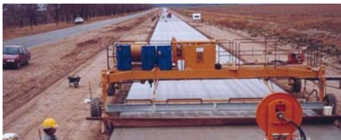
Figura 11– Construcción de la Autopista RPN°20
