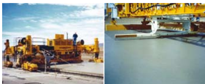
Figura 7 y 8 – Aeropuerto de El Calafate. Provincia de Santa Cruz
