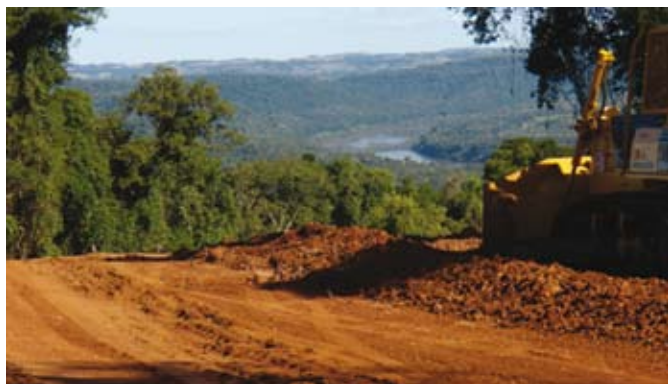
Figura 2. Ejecución de la Ruta Provincial N° 2. Esta ruta atraviesa la Reserva de Biósfera Yabotí e ingresa al Parque Provincial Moconá. (Foto DPV, Misiones).
