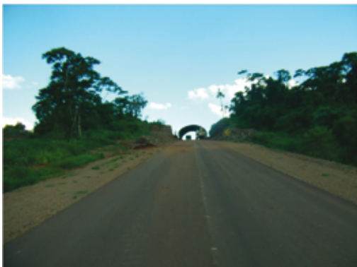
Fotografía 2. Etapa constructiva del ecoducto de la RN N° 101, tramo RP N° 19 – Piñalito. Provincia de Misiones. (Foto DPV, Misiones)
