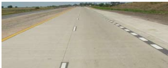
Figura 25 – Sobreancho de carril externo
