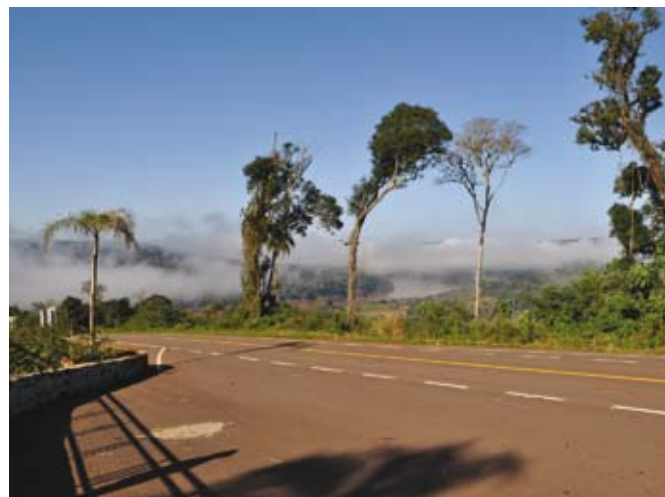
Vista de la obra terminada
