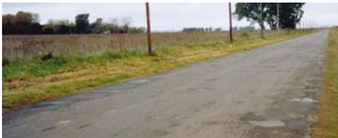
Figura 17– Pavimento flexible existente
