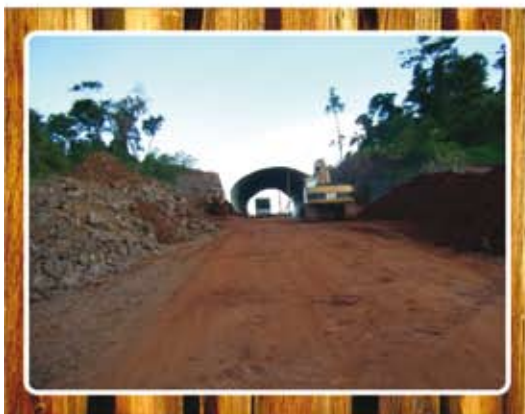
Fotografía 4. Etapa constructiva del ecoducto de la RN N° 101, tramo RP N° 19 – Piñalito. Provincia de Misiones. (Foto DPV, Misiones).
