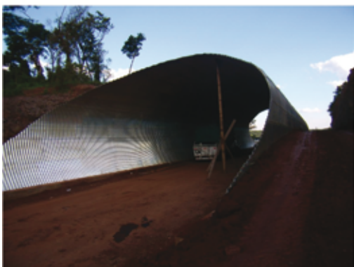
Fotografía 3. Detalle de la bóveda de chapa ondulada MP 152-S. (Foto DPV, Misiones)
