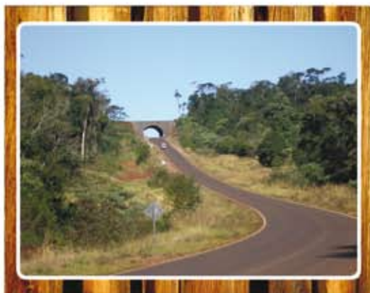
Fotografía 7. Ecoducto de la RN N° 101, tramo RP N° 19 – Piñalito. Provincia de Misiones. Mes de Junio de 2009. (Foto DPV, Misiones).
