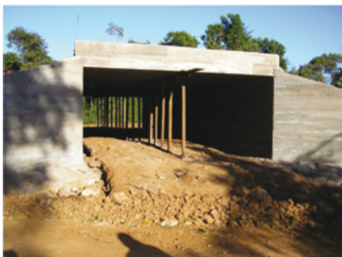
Fotografía 11. Etapa constructiva de un Pasafauna subvial tipo seco. Ruta Provincial N° 2, tramo: Paraíso – Salto del Moconá. (Foto DPV, Misiones).
