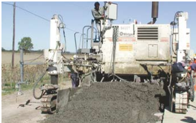
Figura 18– Ejecución del whitetopping
