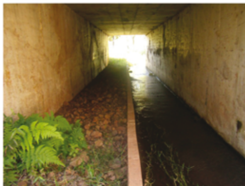
Fotografía 12. Sustrato natural para el paso de la fauna. Pasafauna Subvial de tipo mixto. Ruta Nacional N° 101, tramo RP N° 19 – Piñalito. Provincia de Misiones. (Foto DPV, Misiones).
