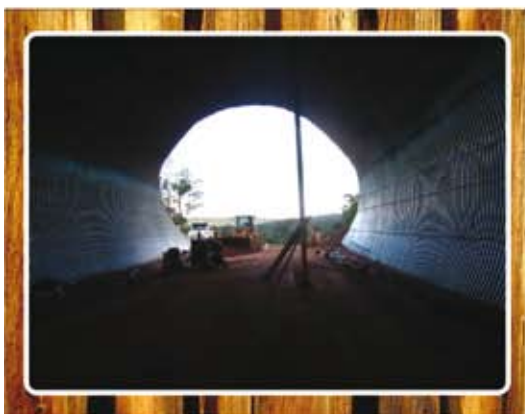
Fotografía 5. Etapa constructiva del ecoducto de la RN N° 101, tramo RP N° 19 – Piñalito. Provincia de Misiones. (Foto DPV, Misiones).
