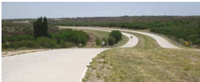
Figura 12– Autopista RPN°20 en servicio
