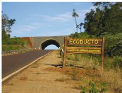
Fotografía 1. Ecoducto construido en la RN N° 101, tramo RP N° 19 – Piñalito. Provincia de Misiones. (Foto DPV, Misiones)
