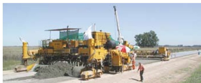
Figura 15 – Construcción de la Autovía Ruta Provincial N°6. Provincia de Buenos Aires
