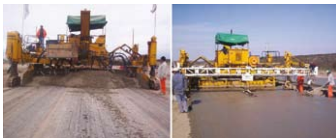
Figura 13 y 14 – Construcción de la Autovía Ruta Provincial N°55. Provincia de San Luis
