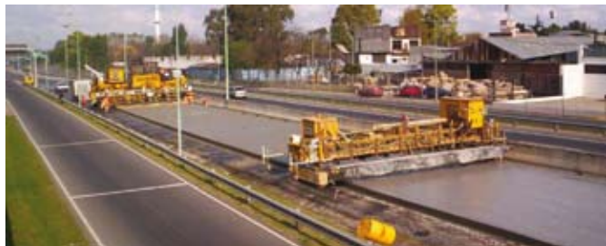
Figura 20- Ejecución del Whitetopping
