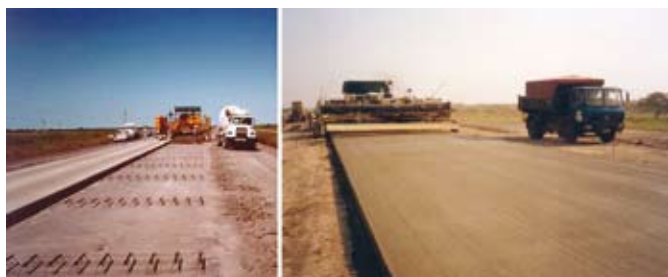
Figura 2 y 3 – Construcción de los distintos tramos
