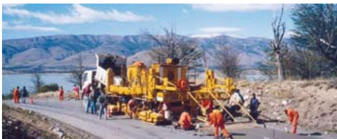
Figura 22- Ejecución del Camino a los miradores
