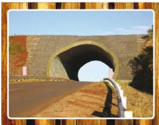
Fotografía 6. Ecoducto de la RN N° 101, tramo RP N° 19 – Piñalito. Provincia de Misiones. Mes de Junio de 2009. (Foto DPV, Misiones).
