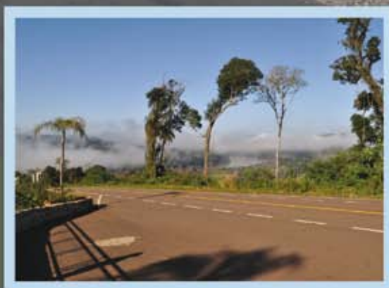
OBRA RUTA PROVINCIAL 2
