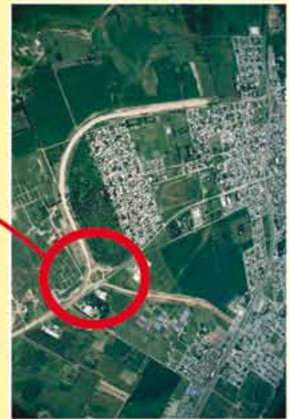
Ruta Nº 6 Fotografía aérea El Tridente Rotonda San Felipe Tramo 6 sección 2
