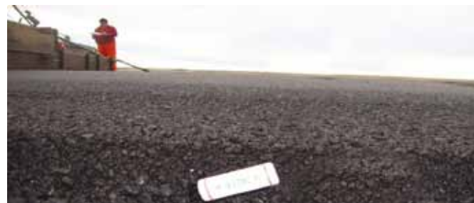
Foto N°3 Verificación de la temperatura de la mezcla en la colocación
