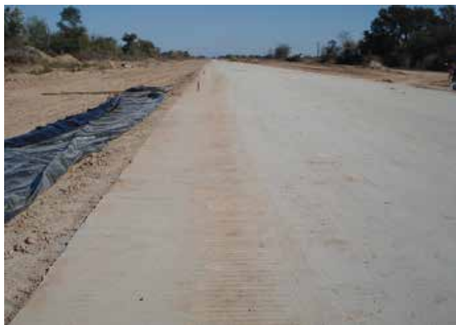
Figura 8: Base de relleno fluido cementicio o de densidad controlada para tránsito liviano
