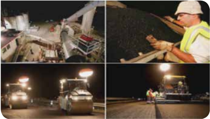
Figura 5: Compactación de mezcla GB5®0/14 con 35% de reciclado y betún 35/45 semioxidado cerca de Toulouse. Densidad in situ: 97%; módulo (15°C y 10 Hz): 15.100 MPa
