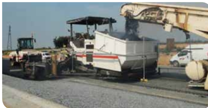
Extendido de mezcla GB5 ® 0/14 con betún modificado Biprène ® 41. Capa de base en el enlace entre la autopista A-13 y la autovía RD613 (Operador: Sanef)
