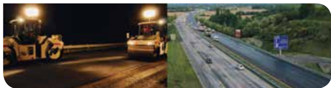
Figura 6: Obra de 31.000 t de GB5® 0/14 en la autopista A41N & A43 (red AREA) en la región alpina. Se emplearon betunes modificados Biprene® y Orthoprene®
