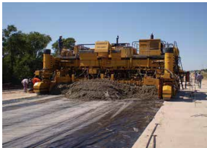
Figura 7: Empleo de film de polietileno sobre base de hormigón pobre
