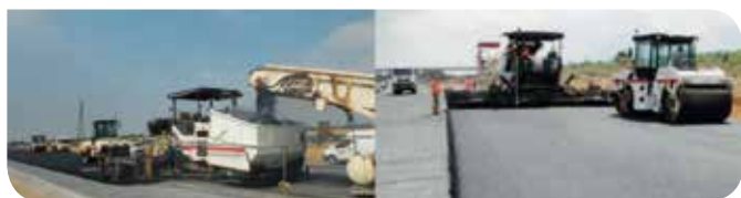
Figura 6: Obra de 31.000 t de GB5® 0/14 en la autopista A41N & A43 (red AREA) en la región alpina. Se emplearon betunes modificados Biprene® y Orthoprene®
