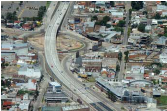
Viaducto R.P. N° 4 sobre Rotonda en Avda. Brig. Gral. J. M. de Rosas
