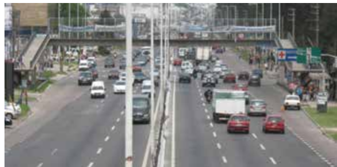
Avda. Brig. Gral. J. M. de Rosas R. N. N°3. Situación actual
