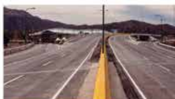
VIADUCTO DEL PORTEZUELO | Prov. de San Luis
